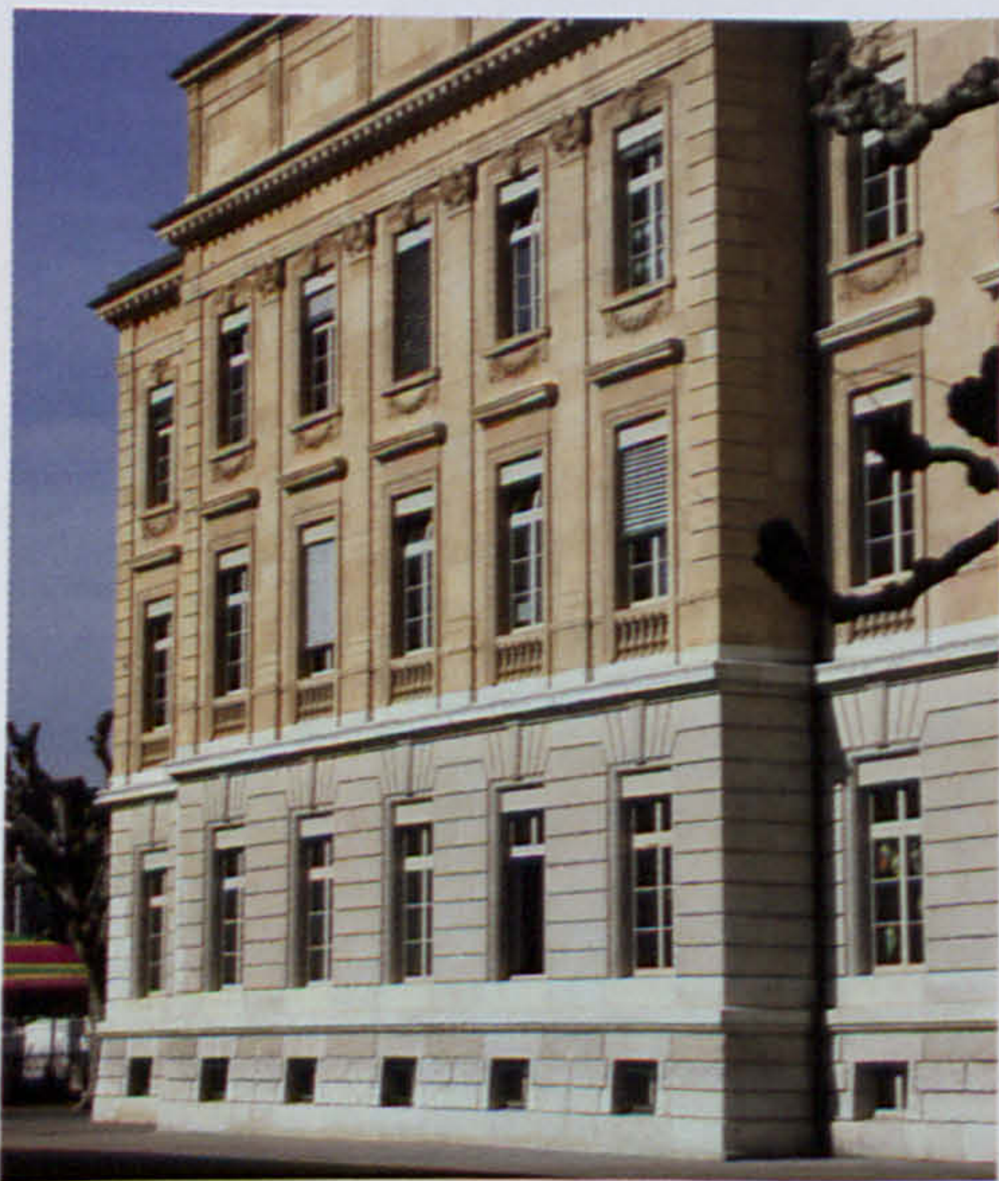
Planche 6C : Collège de la Promenade. Un édifice primitivement prévu en molasse. Son socle en roc du Jura, très peu poreux, provenant de la Vue-des-Alpes, protège le bâtiment de la montée de l'eau capillaire. Ce type de fondation se retrouve dans toutes les constructions soignées édifiées en Pierre Jaune d'Hauterive.
