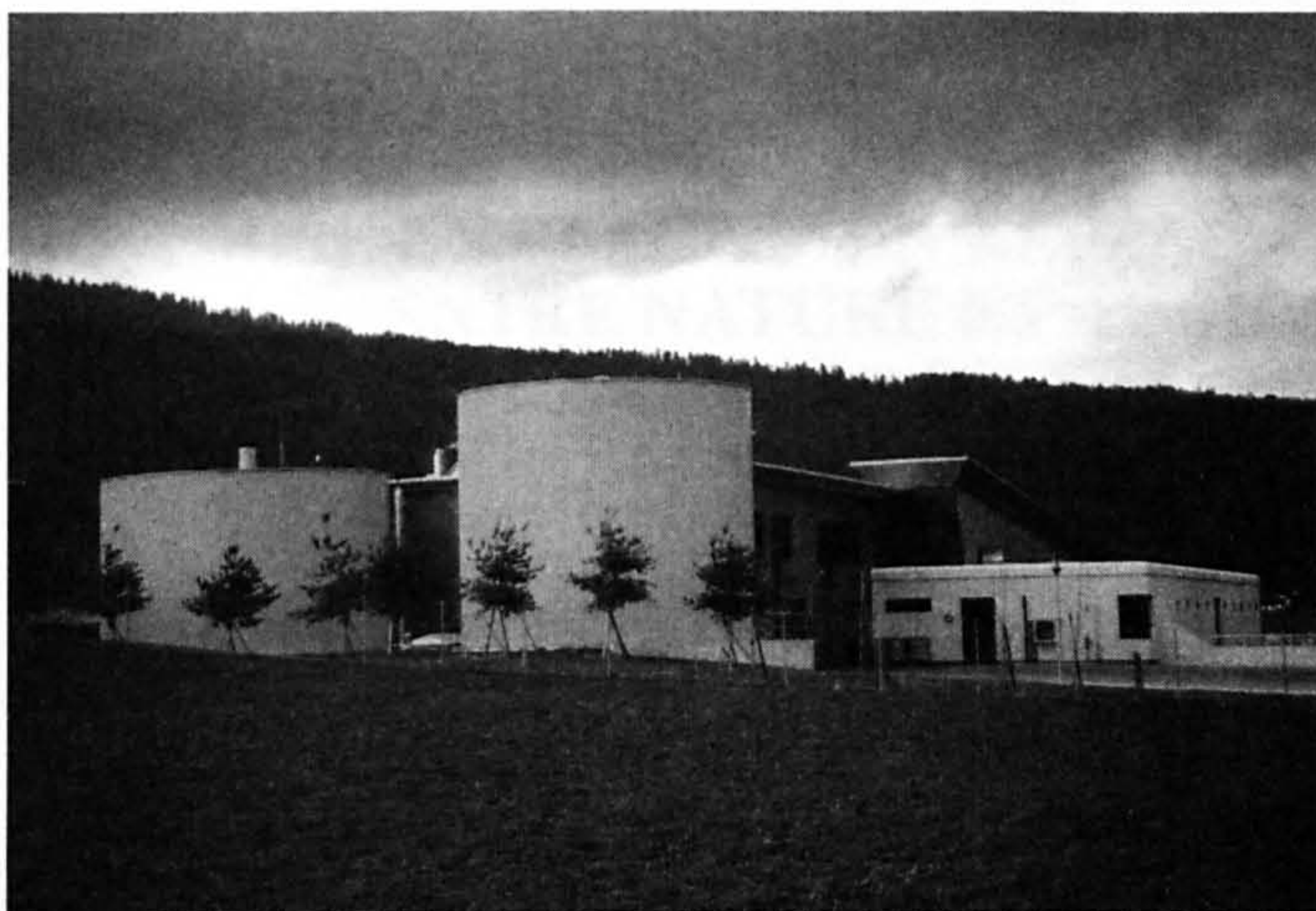
Photo 2 : La nouvelle station d'épuration des eaux du Val-du-Ruz
