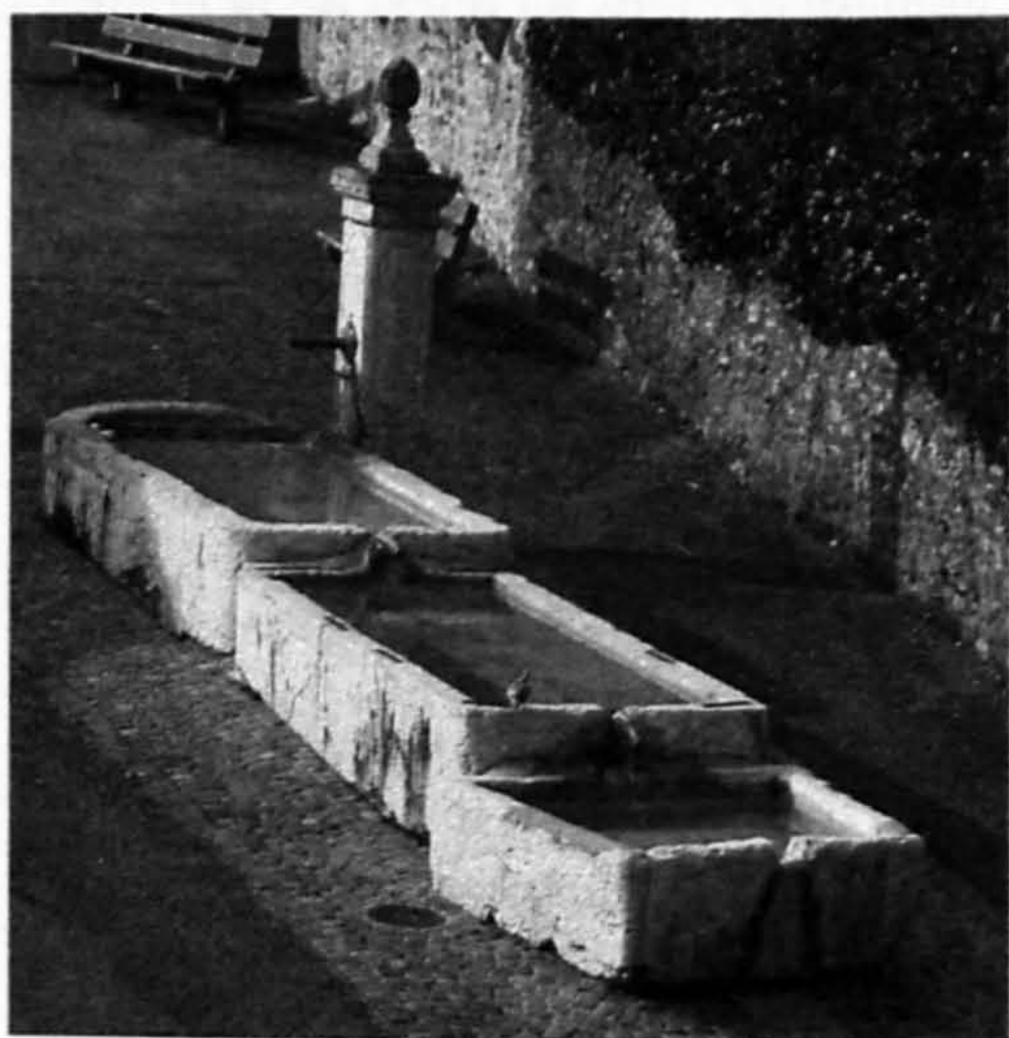
Fig. 2: Fontaine de la Prévôté à Cornaux en calcaire valanginien. Le bassin aval, de 1640, de forme trapézoïdale a été creusé dans un bloc monolithique de calcaire valanginien. C'est l'une des plus anciennes réalisations de cette technique remplaçant à cette époque les bassins construits par l'assemblage de dalles de pierre ajustées. Les deux autres bassins monolithiques à bords parallèles datent de la fin du XVIII e siècle.
