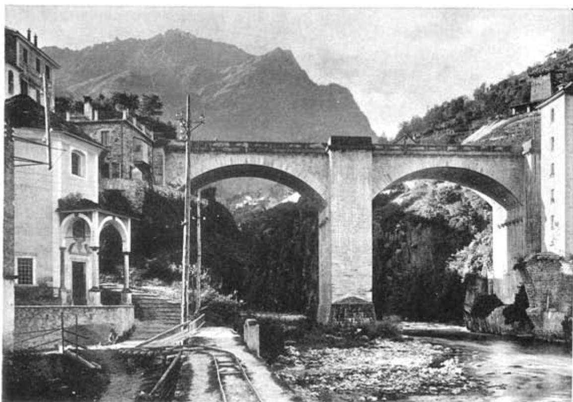
LE PONT DE CREVOLA. ÉTAT ACTUEL
