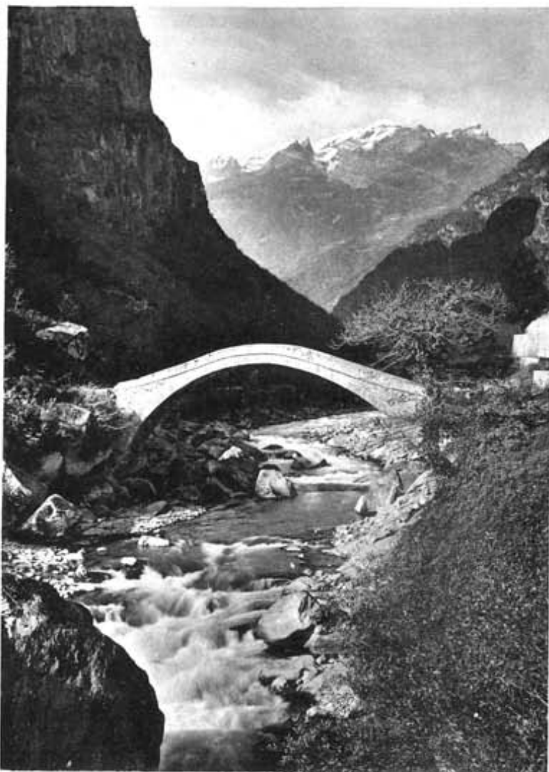
VIEUX PONT SUR LA DOVERIA
