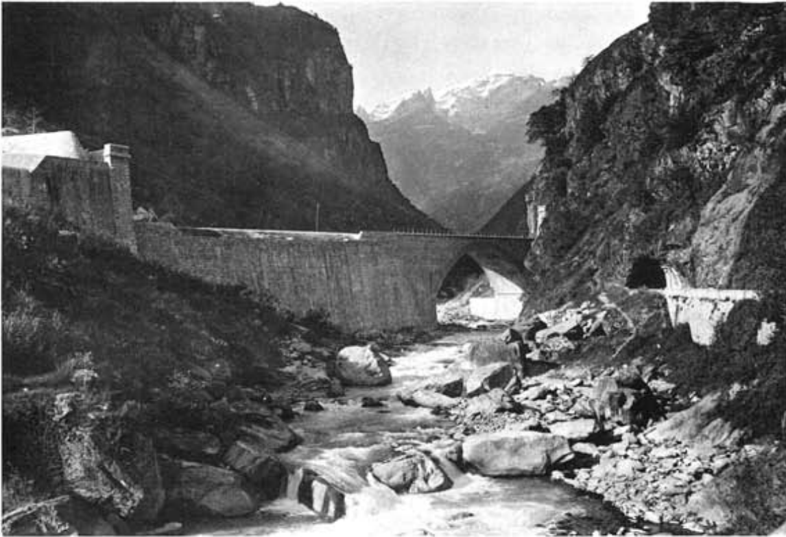
LA GALERIE DE CREVOLA ET LE PONT DU CHEMIN DE FER
