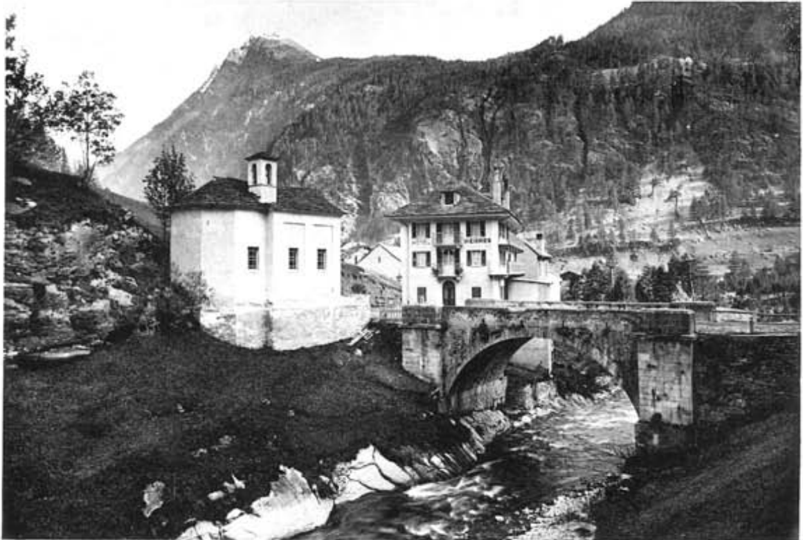
PONT SUR LE KRUMMBACH A ALGABY
