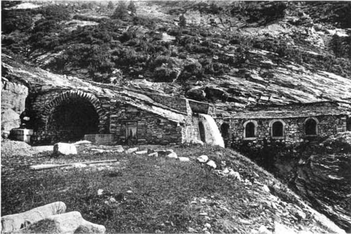
GALERIE VENETZ ET CASCADE DE KALTWASSER
