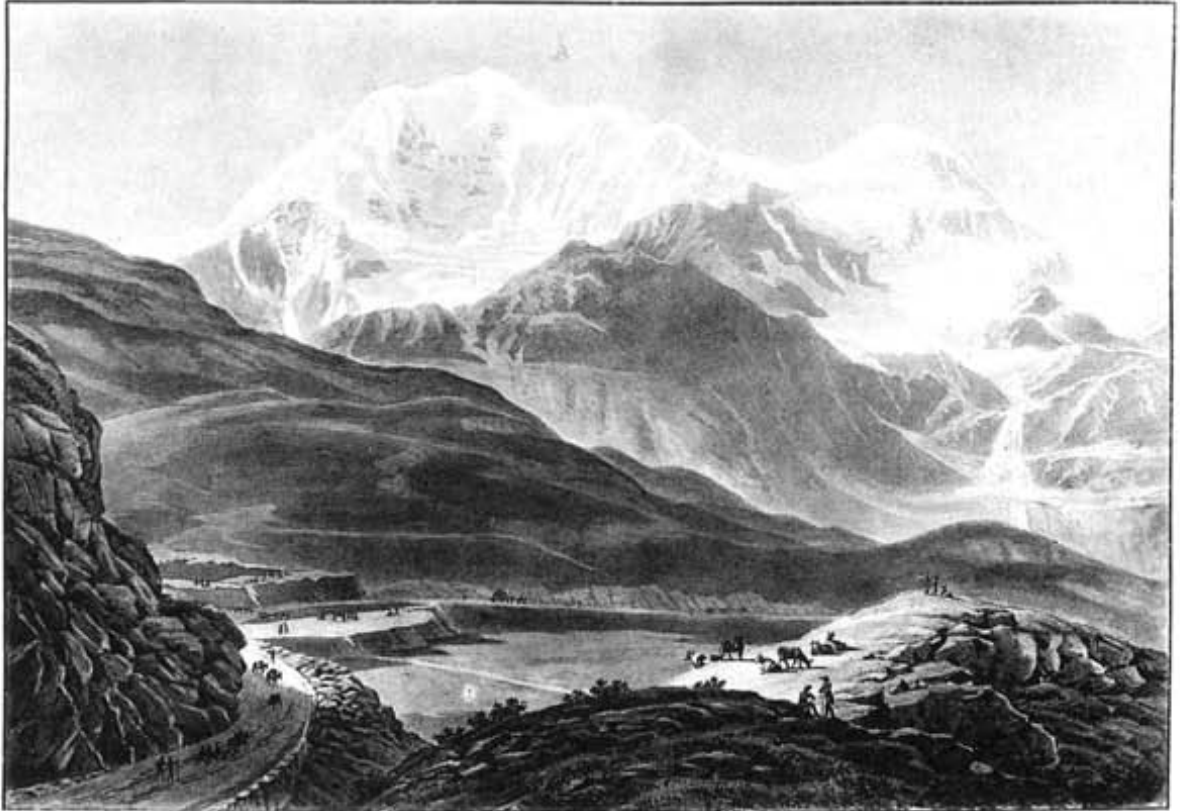
LE PLATEAU DU SIMPLON ET LES TRAVAUX DE L'HOSPICE EN 1811 Gravure de Lory
