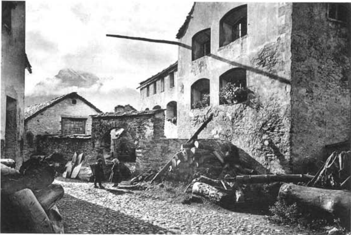
LE GASTHOF, ANCIENNE AUBERGE A SIMPLON, CONSTRUIT EN 1648
