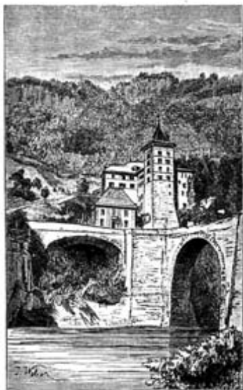
Brücke und Schloss St. Maurice.
