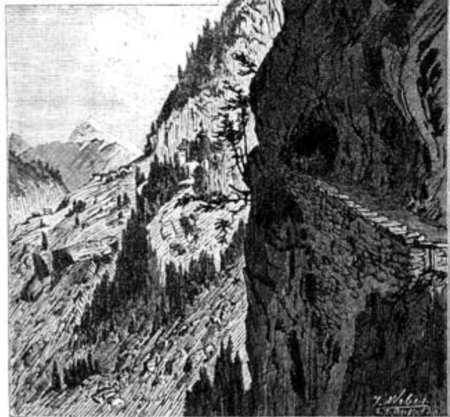
Tunnel von Tête-Noire.
