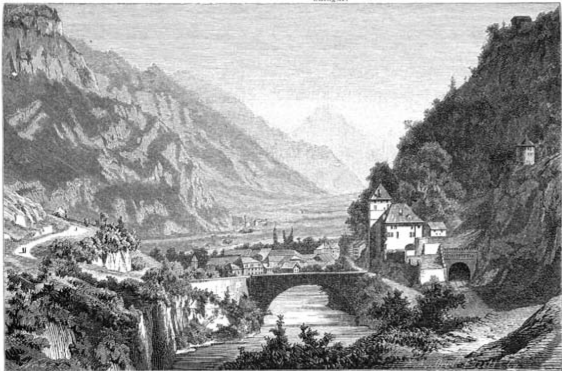
Brücke und Schloss von St. Maurice.
