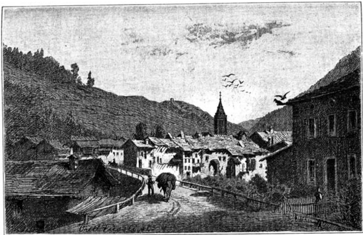
Orsières an der St. Bernhardstrasse
