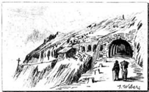
Galerie de Kaltwasser (Eau froide).
