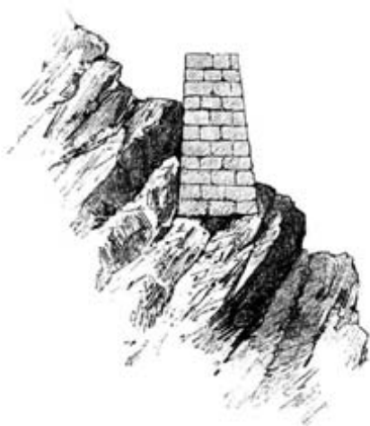
Endiguement de l'avalanche du Torventhorn.
