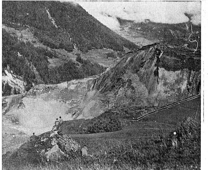
En haut, la gravière, quelques minutes avant l'explosion avec, au fond, sortant d'une couronne de nuages, l'élégante pyramide du Catogne saupoudrée de neige. En bas, le résultat du coup de mine : un vaste cône de 29.000 mètres cubes de matériaux.
