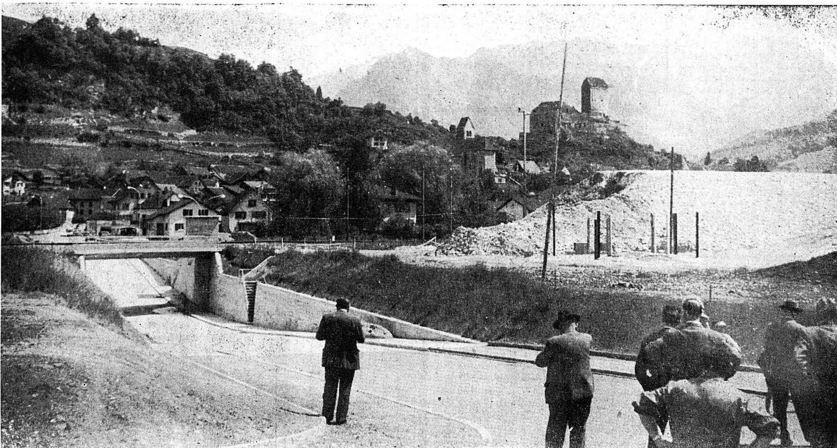
A proximité de Sargans, dont le fier château se détache sur le fond, voici la construction d'un ouvrage d'art. La route de Sargans passe maintenant sous la voie ferrée. A droite, les remblais de la future autoroute qui passera par-dessus la ligne de chemin de fer.
