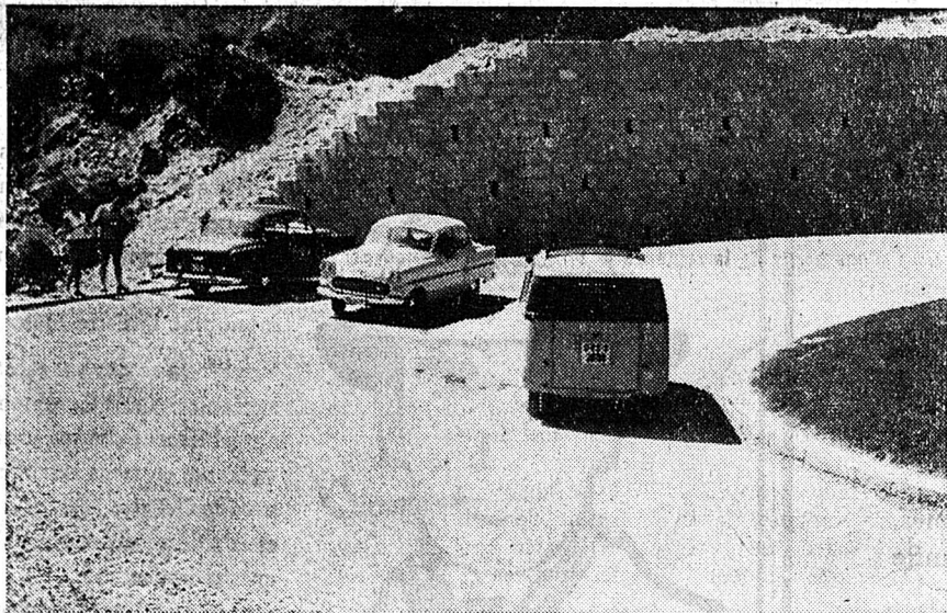
Le virage de La Caffé, étonnant de largeur et d'allure avec ses 14 m. au plus grand rayon. S'il le fallait, quatre voitures pourraient facilement s'y tenir de front. (Photo Berreau)
