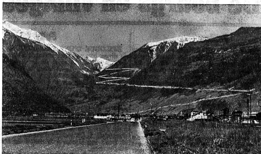
Le tracé d'une partie de la route de la Forclaz vu de la nouvelle artère cantonale entre Martigny et Charrat
