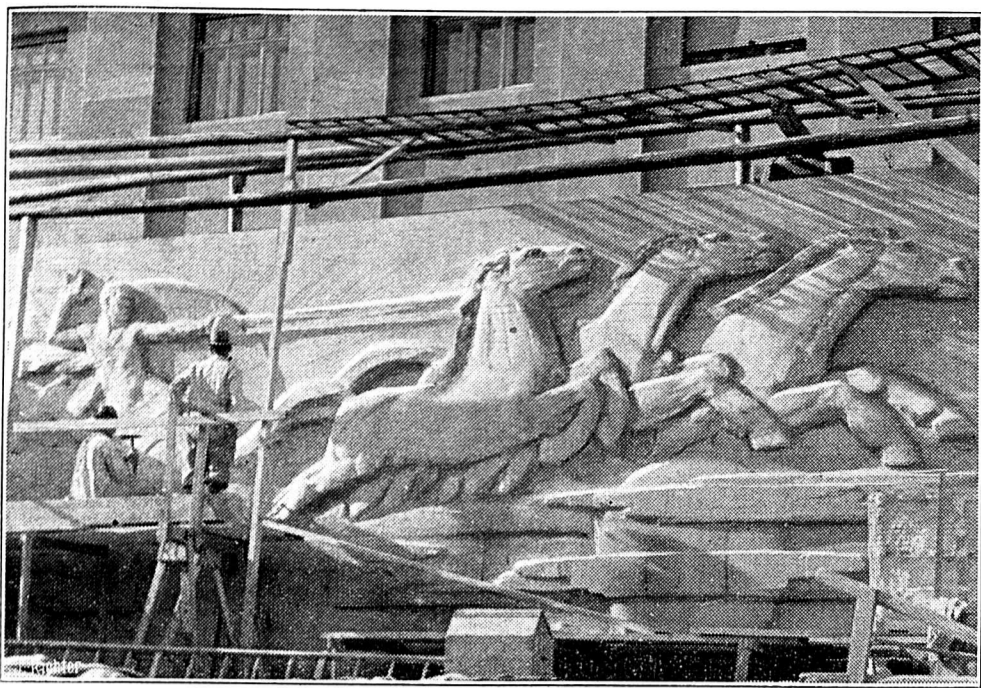
VERS L'ACHEVEMENT D'UNE GRANDE OEUVRE D'ART A NEUCHATEL. — Le grand bas-relief des recherches horlogères de Neuchâtel, œuvre du peintre-sculpteur neuchâtois P. Rothlisberger, est en voie d'achèvement. Voici le « Char du soleil » sculpté dans un mur de 13 m. de long se composant de 80 blocs de pierre jaune d'Hauterive.
