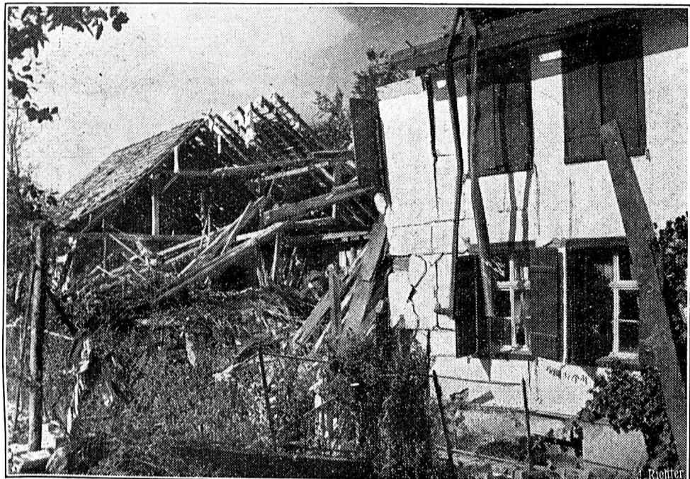
DES BOMBES S'ABATTENT SUR UN VILLAGE THURGOVIEN. — La maison qui a été détruite et dans laquelle trois membres de la famille Böttschi ont été tués. (No de censure VI Y 8805.)
