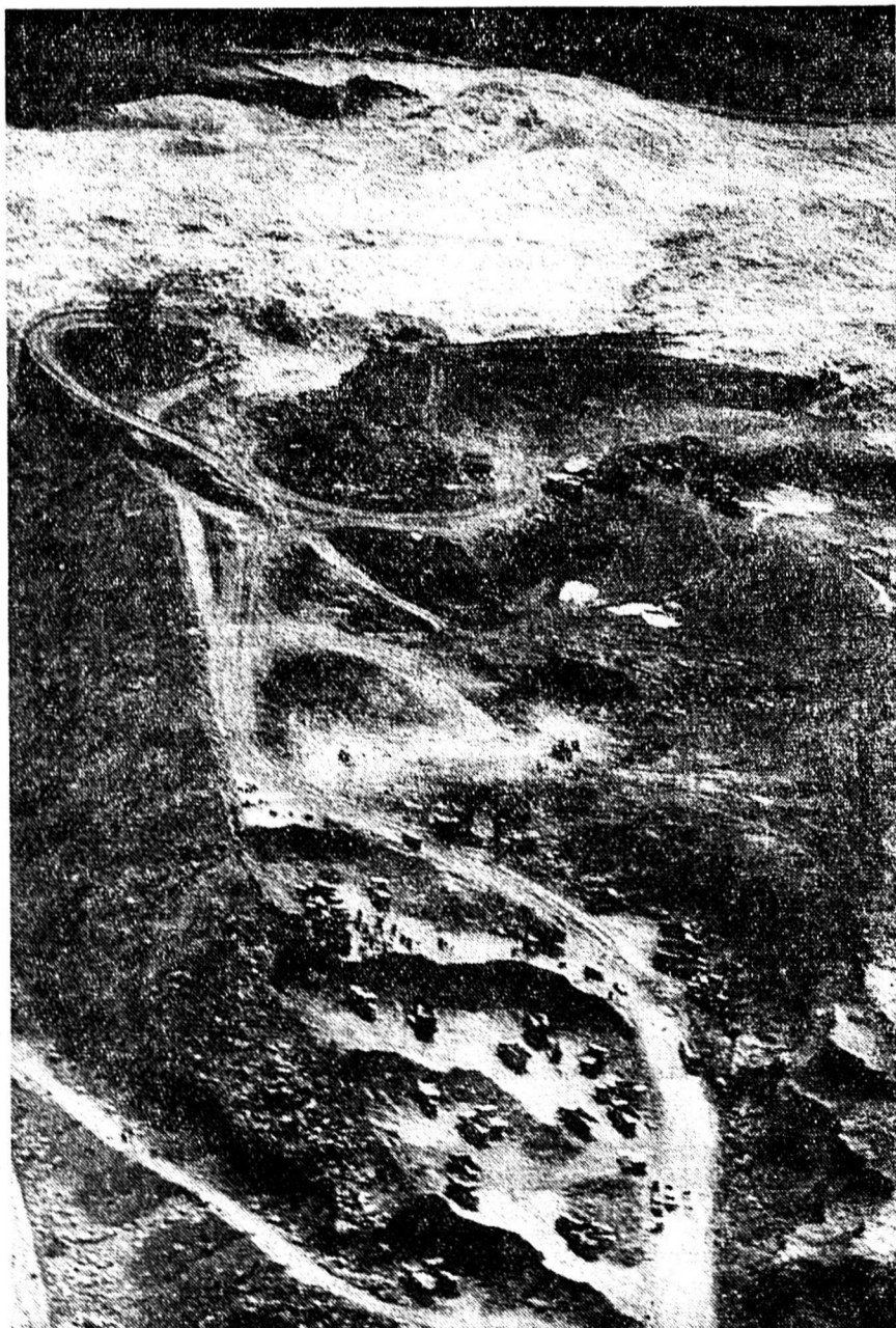
Vu d'avion, le vaste chantier et les innombrables pelles et trax (au premier plan) qui sont utilisés aux travaux de recherches, mais qui, au moment précis où a été faite cette photo ont dû reculer devant la menace du glacier. Tout au fond, on voit la glace qui recouvre les baraquements.
