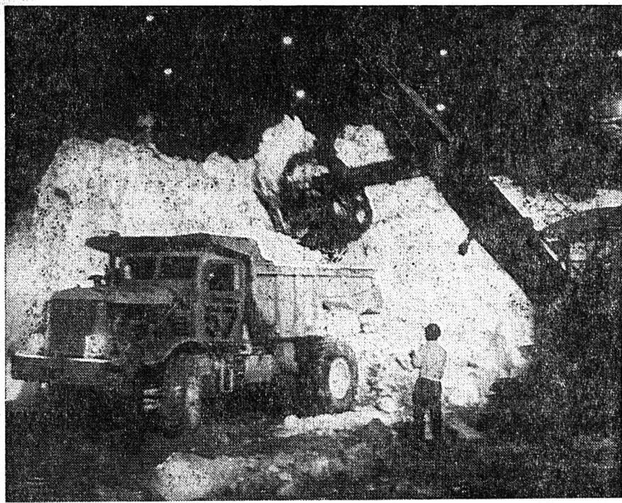
Les pelles mécaniques travaillent sans relâche pour dégager les corps et charger les camions qui iront à 500 m. plus loin déverser la neige et la glace.
