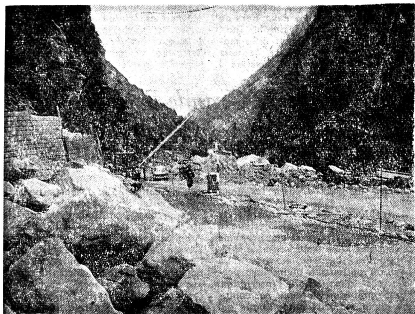
A la sortie du village de Gondo, en direction de l'Italie, on procède à d'importants travaux de réfection et d'agrandissement de la chaussée, qui, une fois terminée, sera une magnifique artère.
