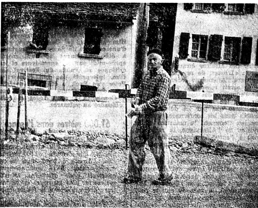
Les ouvriers travaillant sur le chantier de la route du Simplon, sont en majeure partie d'origine italienne et vivent sur sol italien. Etant payés selon les tarifs en vigueur en Suisse, on peut dès lors comprendre le sourire de cet ouvrier qui vient de toucher sa paye et qui tient encore à la main les billets de 100 francs suisses.
