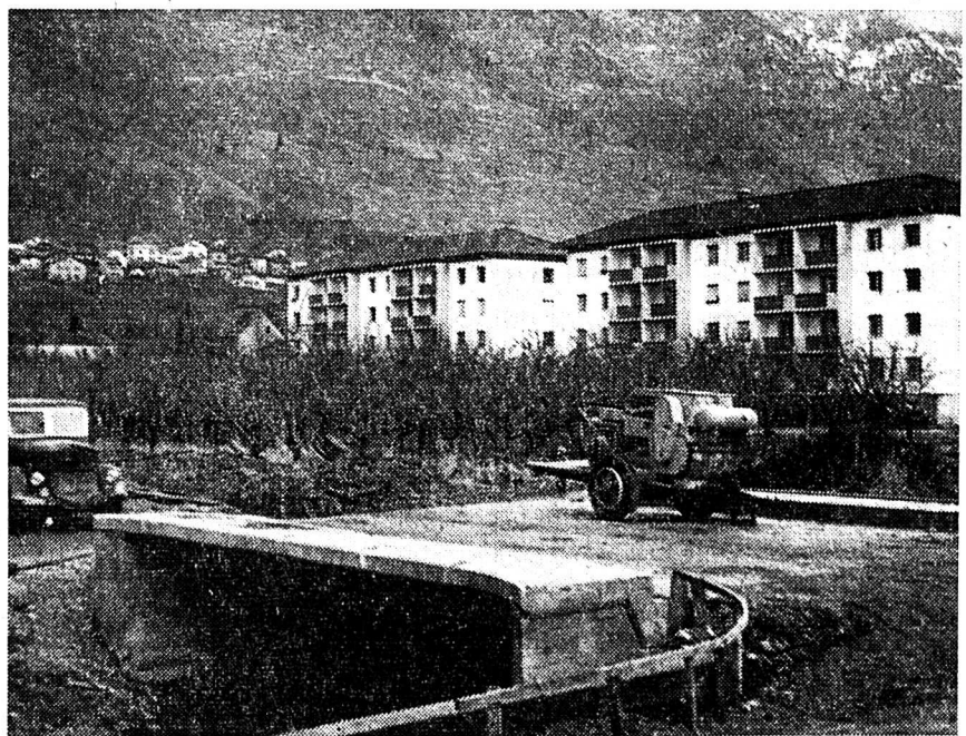
Les ouvriers sont en train d'achever un nouveau pont près de Vers l'Eglise, à proximité de Martigny, pour permettre le passage de la nouvelle route.
