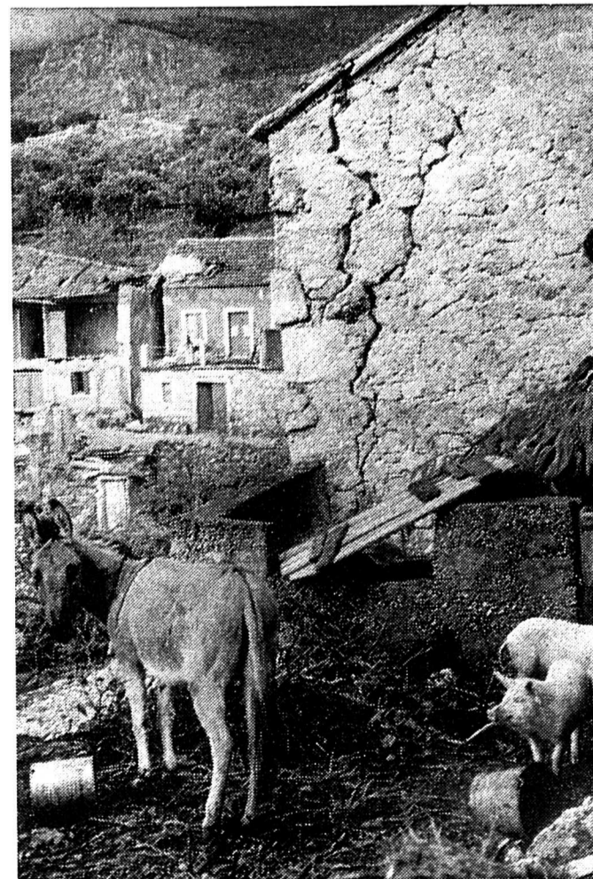
Un tremblement de terre a ravagé la région de Split, en Yougoslavie. Nous voyons ici les dégâts causés par le séisme.
