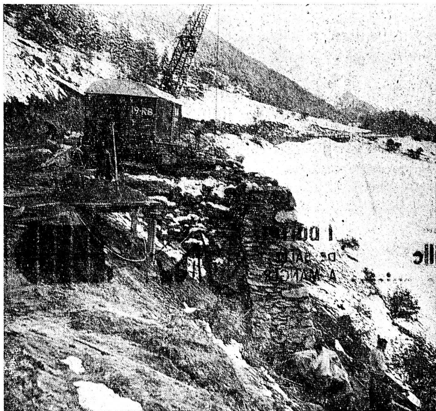
Malgré les premières neiges, on continue à procéder à l'élargissement de la route du Saint-Bernard près de Bourg-Saint-Pierre. Un énorme mur de soutènement est ici en construction.
