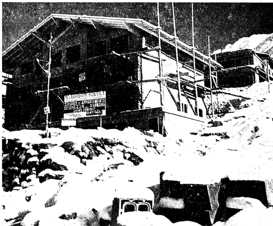
Verbier sous la première neige, mais en pleine construction.
