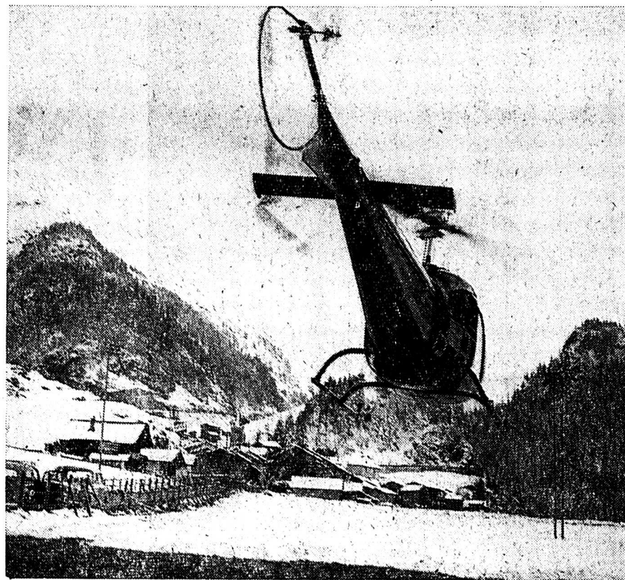
L'hiver est là. A Bourg-Saint-Pierre l'hélicoptère de Martignoni redescend le matériel qui, à 2 000 m., a permis de construire une conduite d'amenée d'eau pour le barrage des Toules.
