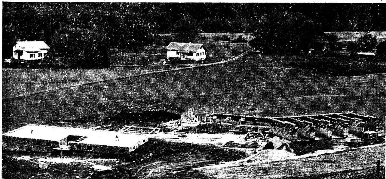
Les nouveaux bâtiments de douane d'Orsières sortent de terre. A gauche et au centre, les logements des douaniers, à droite, les garages.
