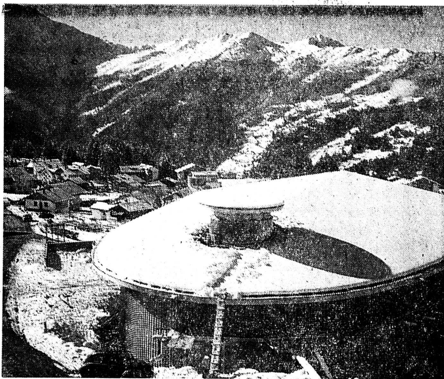
Vue de Verbier, au premier plan, la toiture en coupole de l'église en construction.
