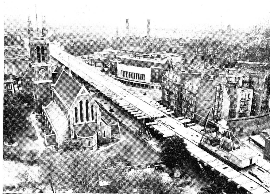
Pour résoudre une partie au moins des problèmes de la circulation, la ville de Londres a prévu la somme de 516 millions de francs suisses pour l'amélioration des voies de sortie en direction ouest. La construction la plus importante est celle d'une autoroute sur pilotis qui, longue d'un kilomètre à peine, reviendra à 156 millions de francs. Voici une vue aérienne de ce tronçon dont la remise à la circulation est prévue pour le mois de mai prochain.
