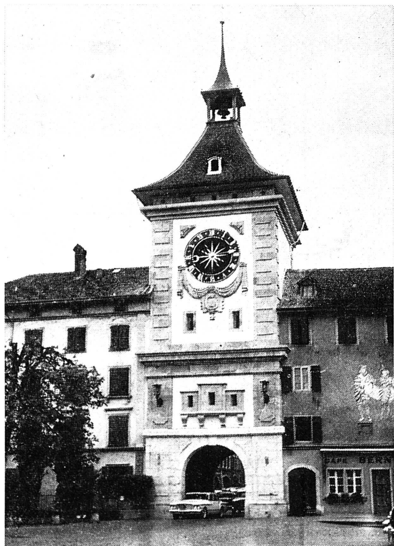
La porte de Morat, que tous les automobilistes connaissent bien, vient d'être restaurée. Signalons que cet édifice, merveilleusement proportionné, date du XVIIIe siècle.
