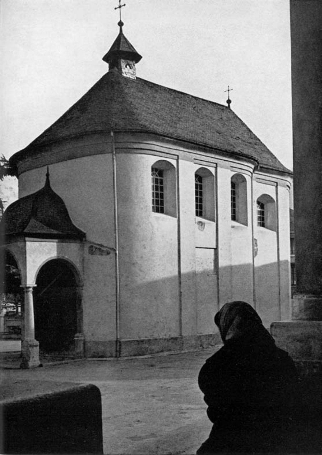
Grâces architecturales : la chapelle du Pont à Monthey
