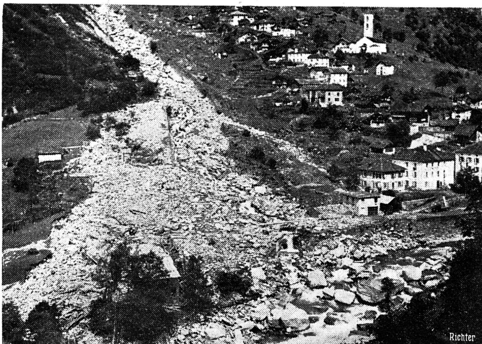
Une image montrant l'ampleur de la catastrophe, dans la vallée Calanca — un désert de pierres à Arvigo — Les dégâts catastrophiques dépassent de beaucoup tout ce que l'on pouvait imaginer. Des maisons entières ont été balayées par les eaux dévalant des montagnes, en certains endroits le sol est recouvert d'une couche épaisse de pierres, de rochers et de boue.
