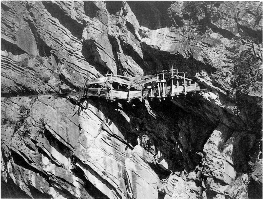
Fig. 23 – Les vestiges originels des bisses sont des témoins archéologiques soumis à des dégradations ou à des destructions du fait de l'action des hommes et des phénomènes naturels. Ici, une des dernières parties conservées du Torrent Neuf de Savièse (état 1991).
