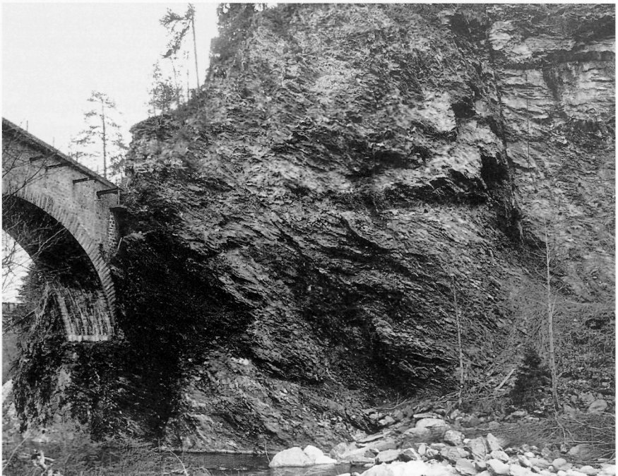
Fig. 1a – Partie nord de la falaise au lieu-dit «Gierner Crest» (état 1983). A gauche, pont de la route construit en 1868.
