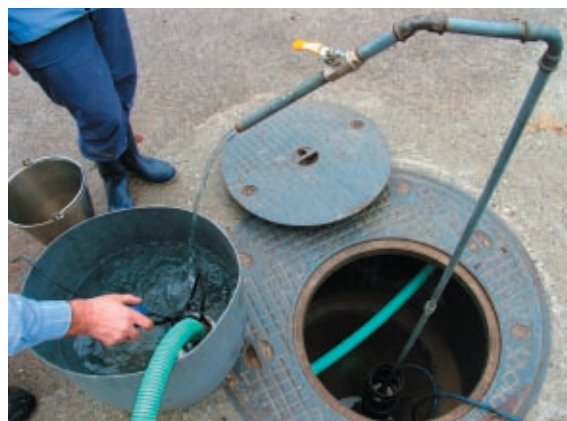
Fig. 5.2: Purgage du forage SG47 au nord-ouest de la DIB à l'aide de la pompe électrique du forage et d'un tuyau en acier
