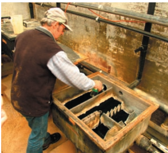
Fig. 1.2: Echantillonnage de l'eau à la sortie du filtre fin de la station d'épuration (Photo: C. Reymond, 2004)
