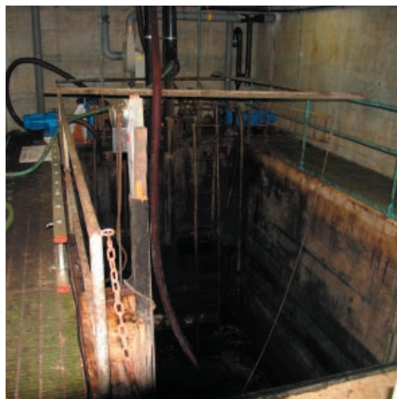
Fig. 6.10: Chambre principale (CP) de la STEP, où les lixiviats de la DIB sont récoltés
