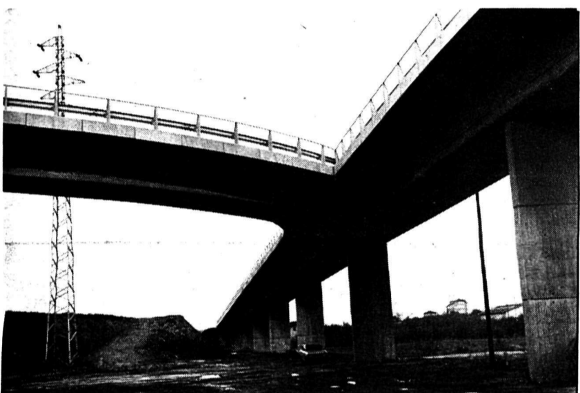
Vue inférieure du pont de Riddes
