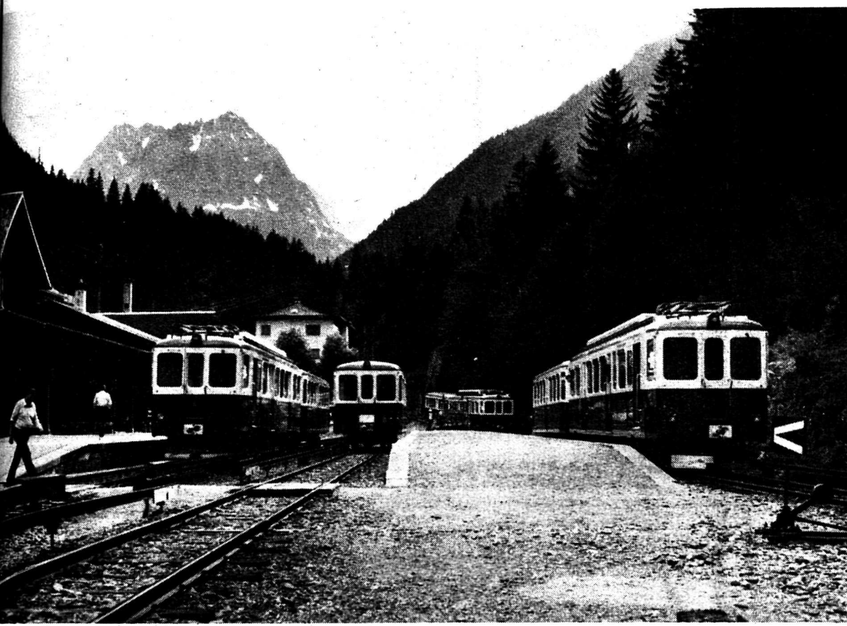
Désenclavement du Valais, ce sera pour le siècle prochain. A quand un Martigny-Chamonix performant?
