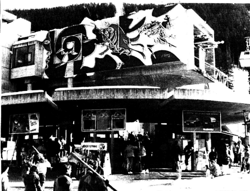
La station de départ des Ruinettes / Les Attelas, à Verbier, ornée d'une œuvre de Hans Erni.
