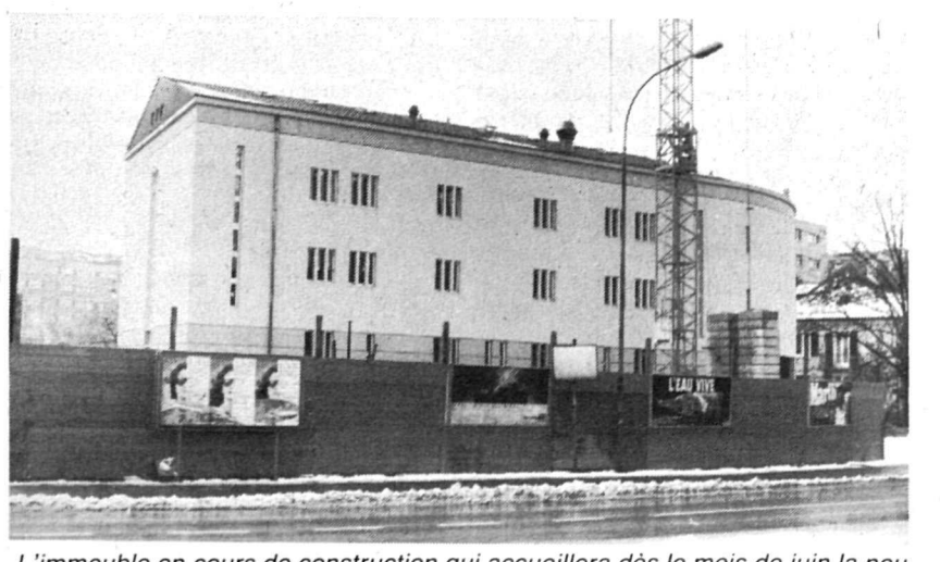
L'immeuble en cours de construction qui accueillera dès le mois de juin la nouvelle Auberge de Jeunesse de la ville de Sion.
