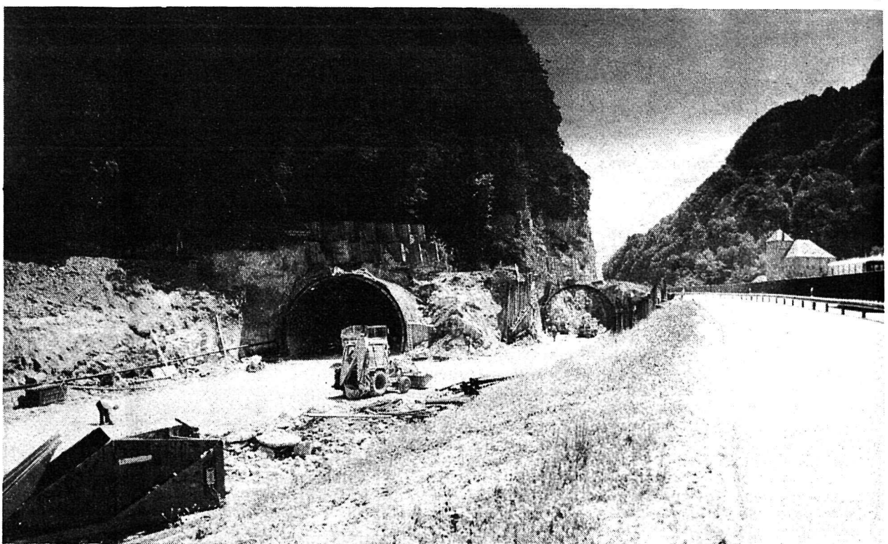
Le portail côté Vaud en pleine excavation et à l'extrême droite le portail côté Valais en préparation. A droite, le château militaire de Saint-Maurice.
