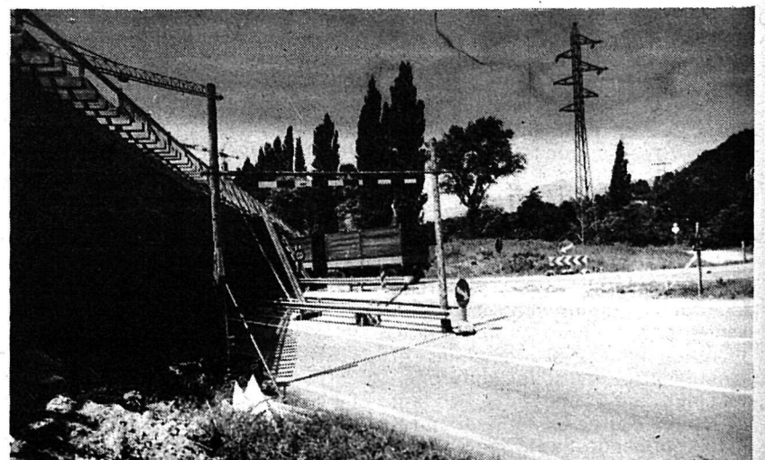
Routiers attention! 4m hauteur maximum dans le sens Saint-Maurice / Bex.
