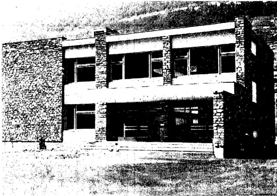
Voici une vue partielle du nouveau groupe scolaire, montrant l'entrée principale. On remarquera leur modernisme de bon goût qui cadre bien avec le paysage environnant. De larges baies vitrées assurent un éclairage judicieux. (photos G. L.)
