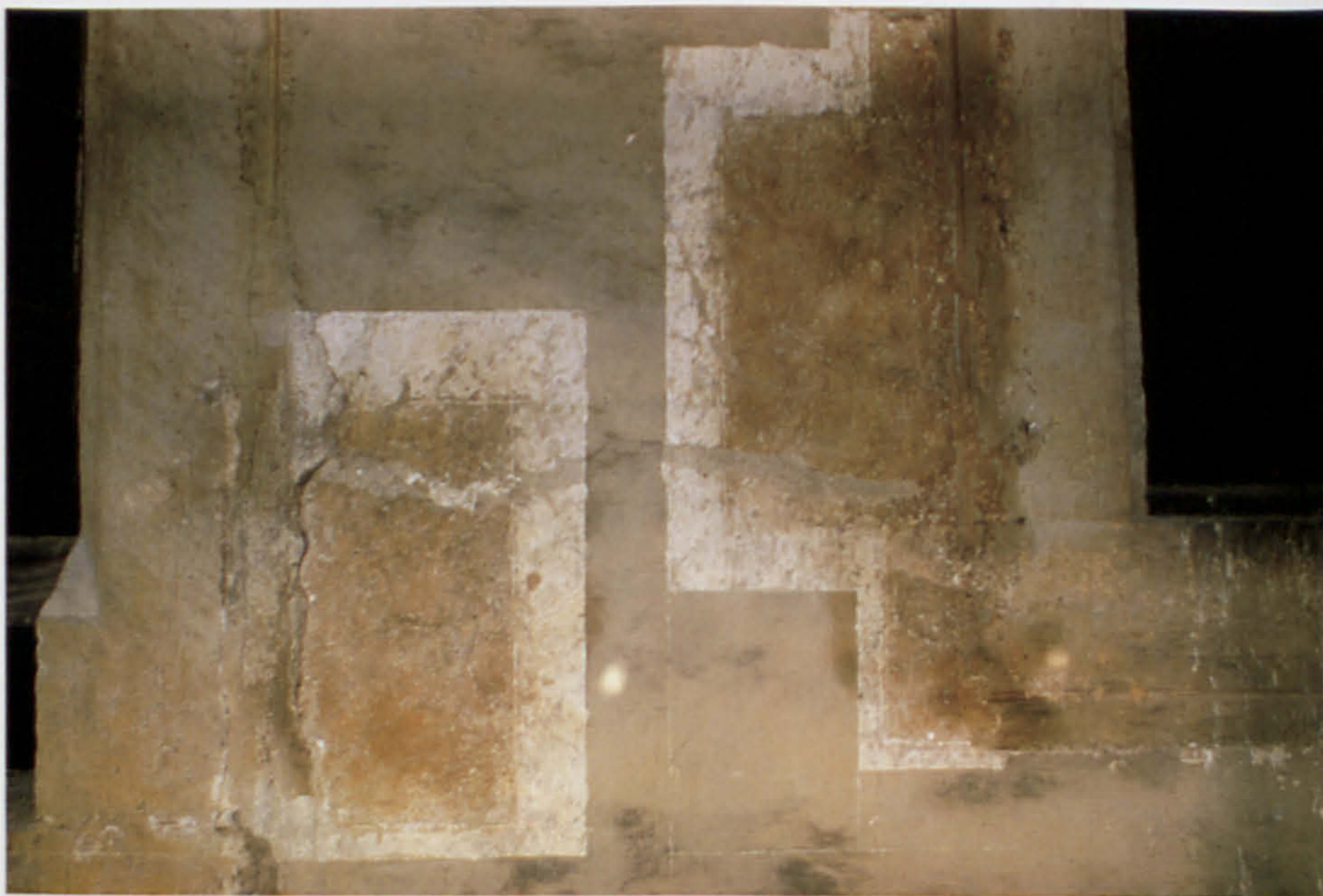
Fig. 2. Peseux, la Maison Sergeans, Grand-Rue N° 13-15. Mise en évidence, par sondages, de la polychromie de façade. (Photo: Atelier de restauration Marc Stähli, Auvonnier.)
