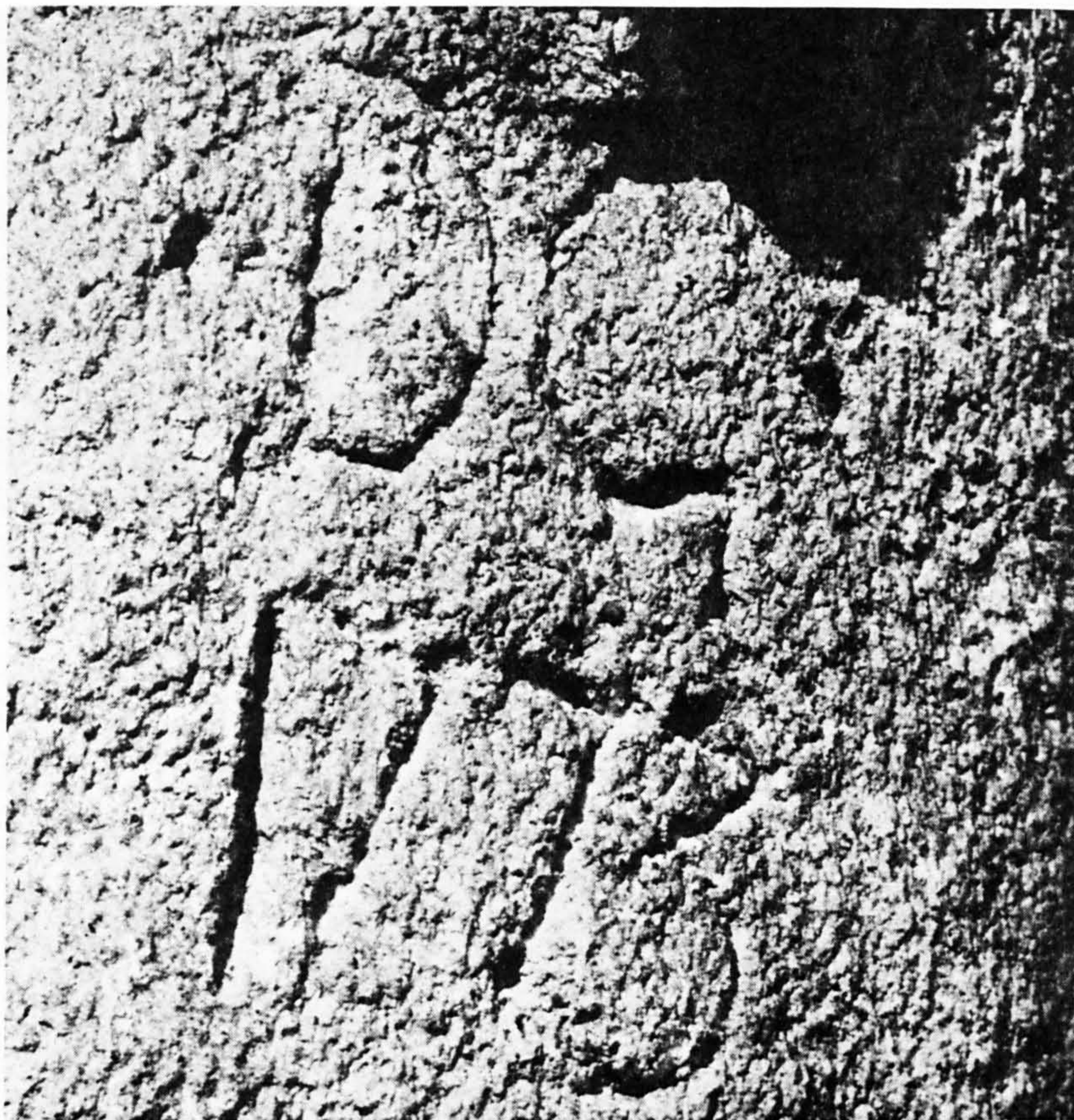
Fig. 3. — Incision d'une inscription dans le mortier frais en 1773, sur la face est de la tourelle sud-ouest du château de Cressier.
