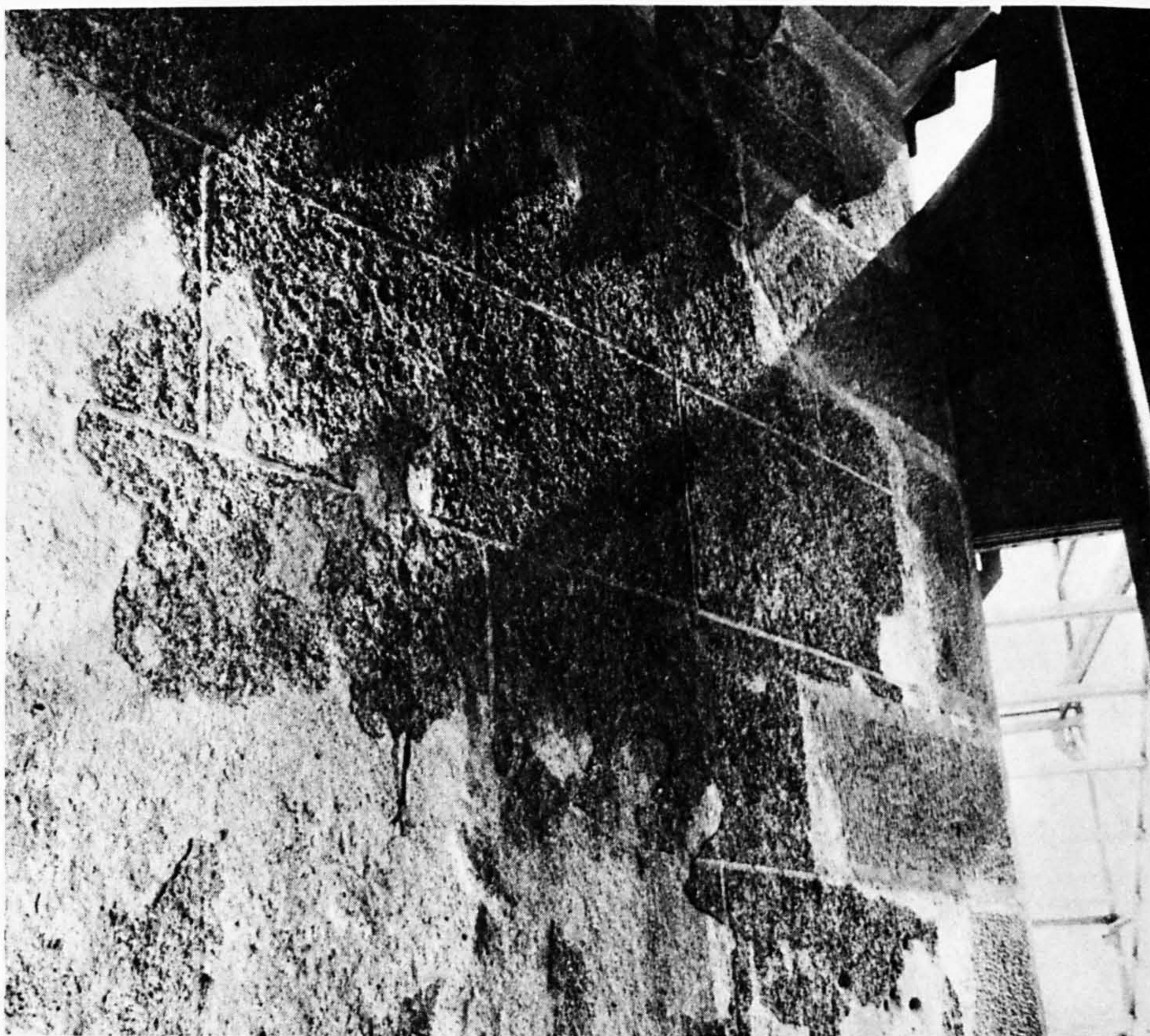
Fig. 4. — Faux appareil et chaîne d'angle rectifiée sur la tourelle d'escalier de la maison n° 29, à Auvernier. (Photographies Monuments et sites)
