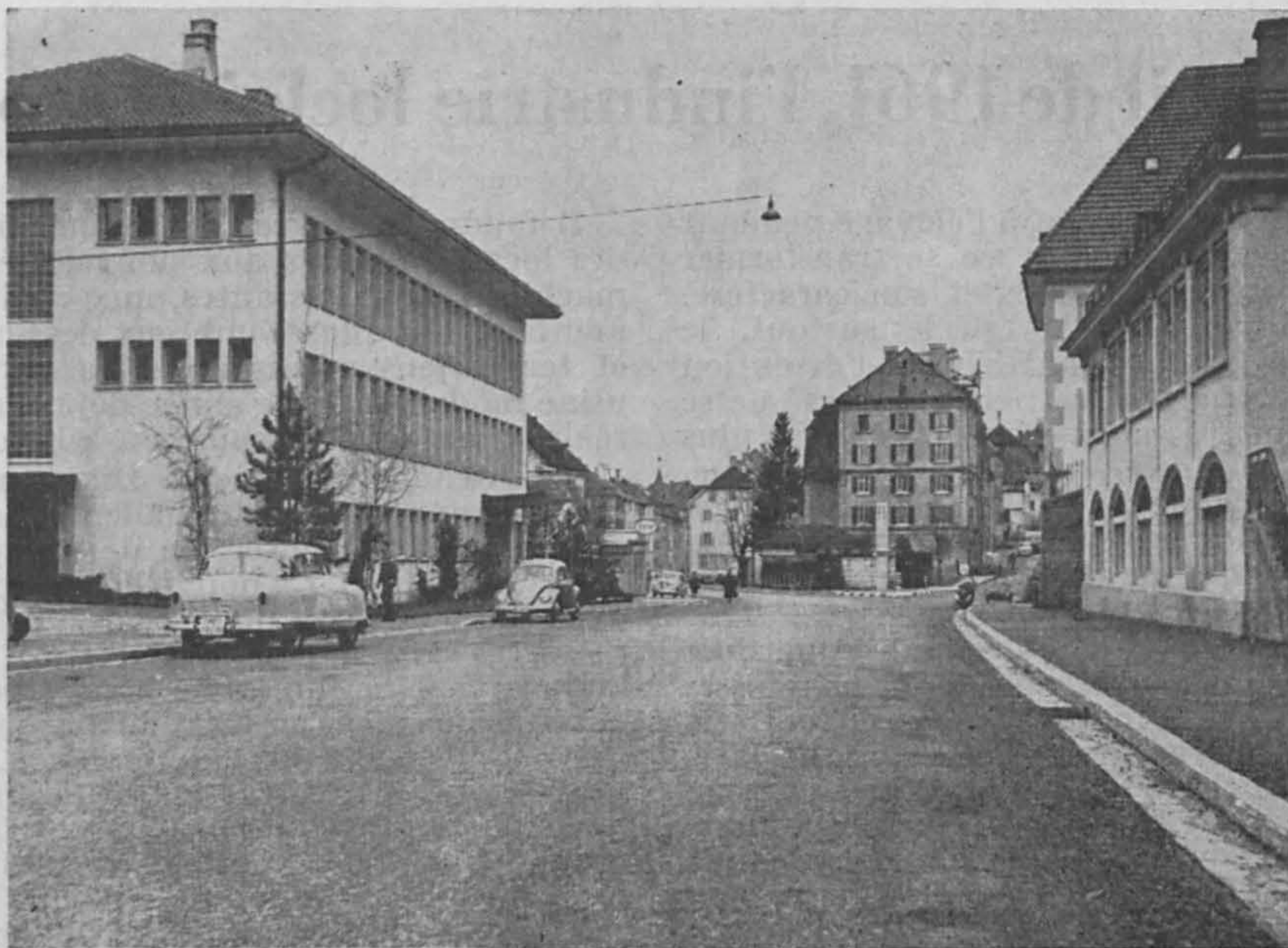
Les travaux d'élargissement de la route cantonale à l'entrée est de la mère commune des Montagnes sont terminés à la grande satisfaction des Loclois et de tous les usagers de la route. A l'arrière-plan de notre photographie: le monument des Girardet. (Press Photo Actualité)
