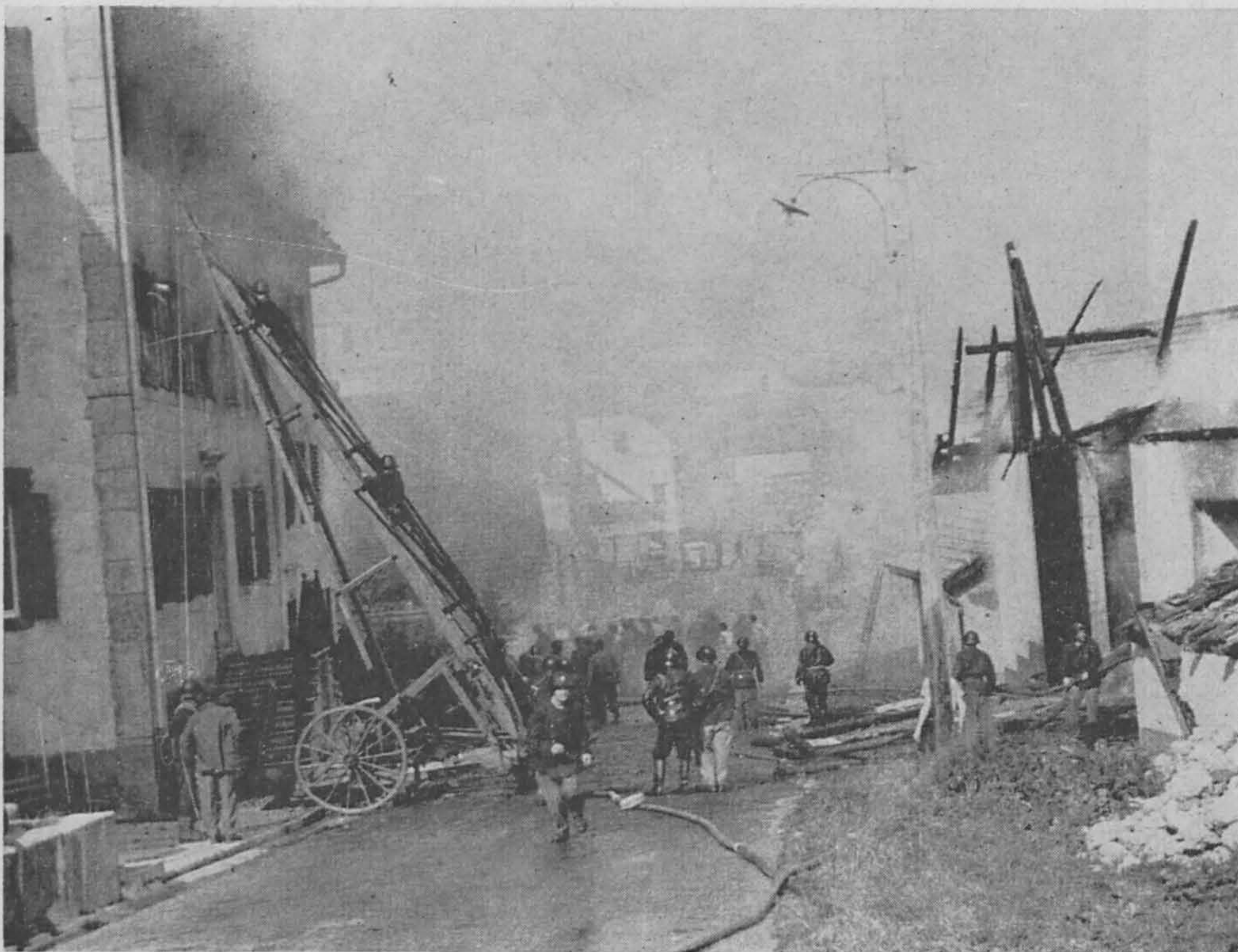
A la Sagne, de part et d'autre de la route du Locle le feu fait rage. A droite, la ferme Boss qui n'est plus que des décombres ; à gauche, les deux maisons locatives, dont toute la partie supérieure est ravagée par les flammes.
