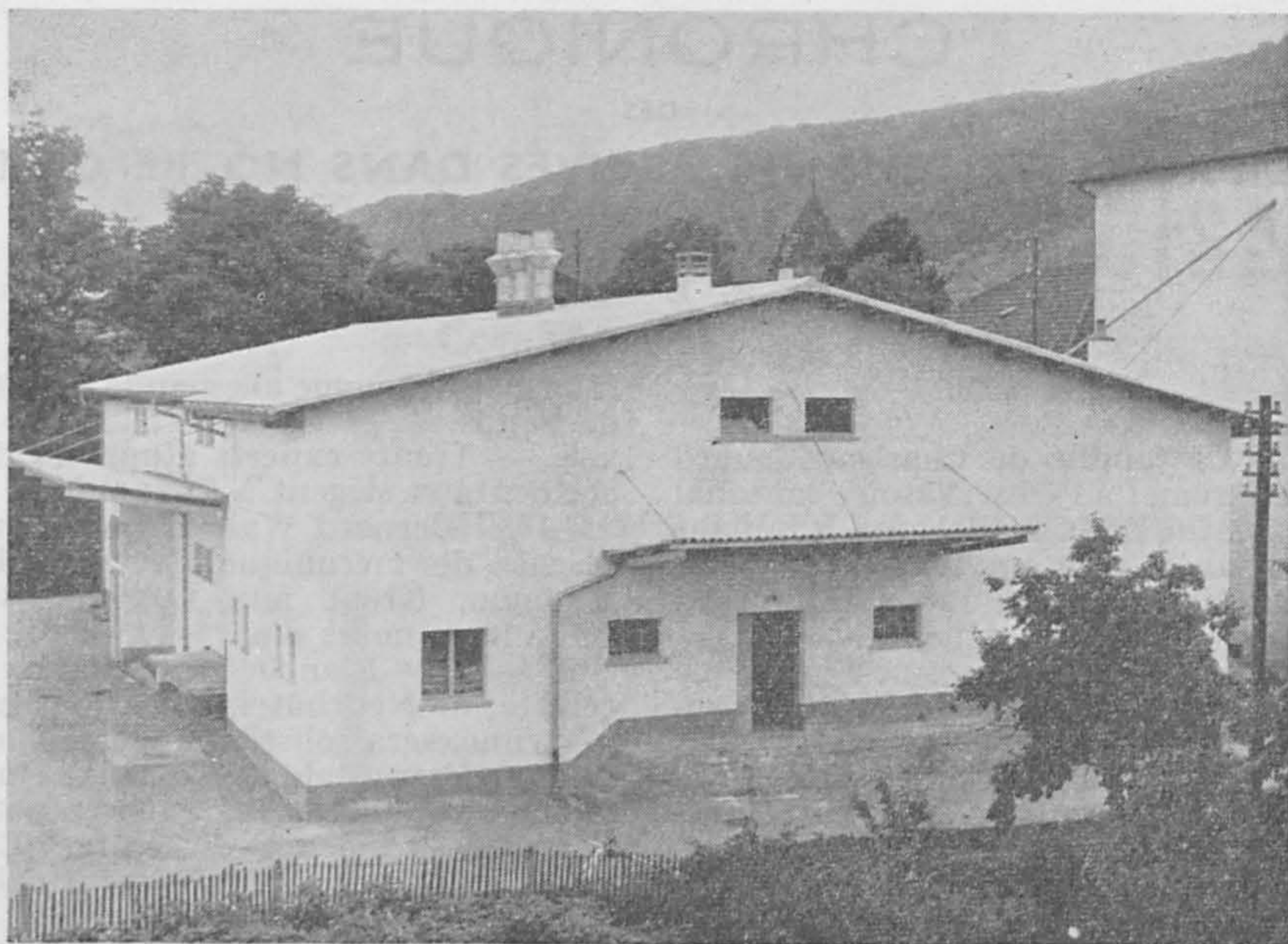
Le nouveau bâtiment de la Coopérative agricole de Cornaux.
