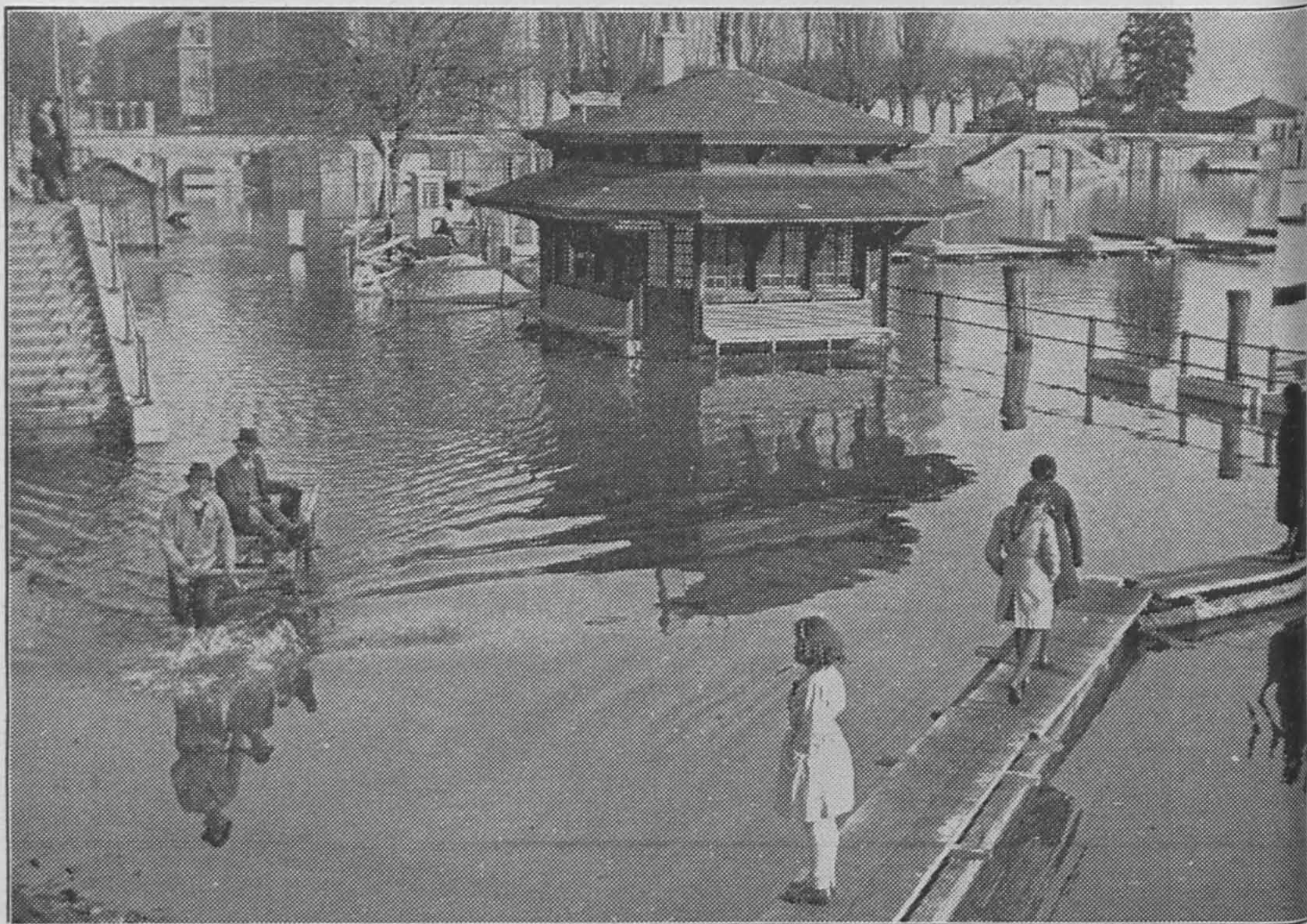
Une passerelle de fortune a dû être installée au port de Neuchâtel pour atteindre les bateaux à vapeur
