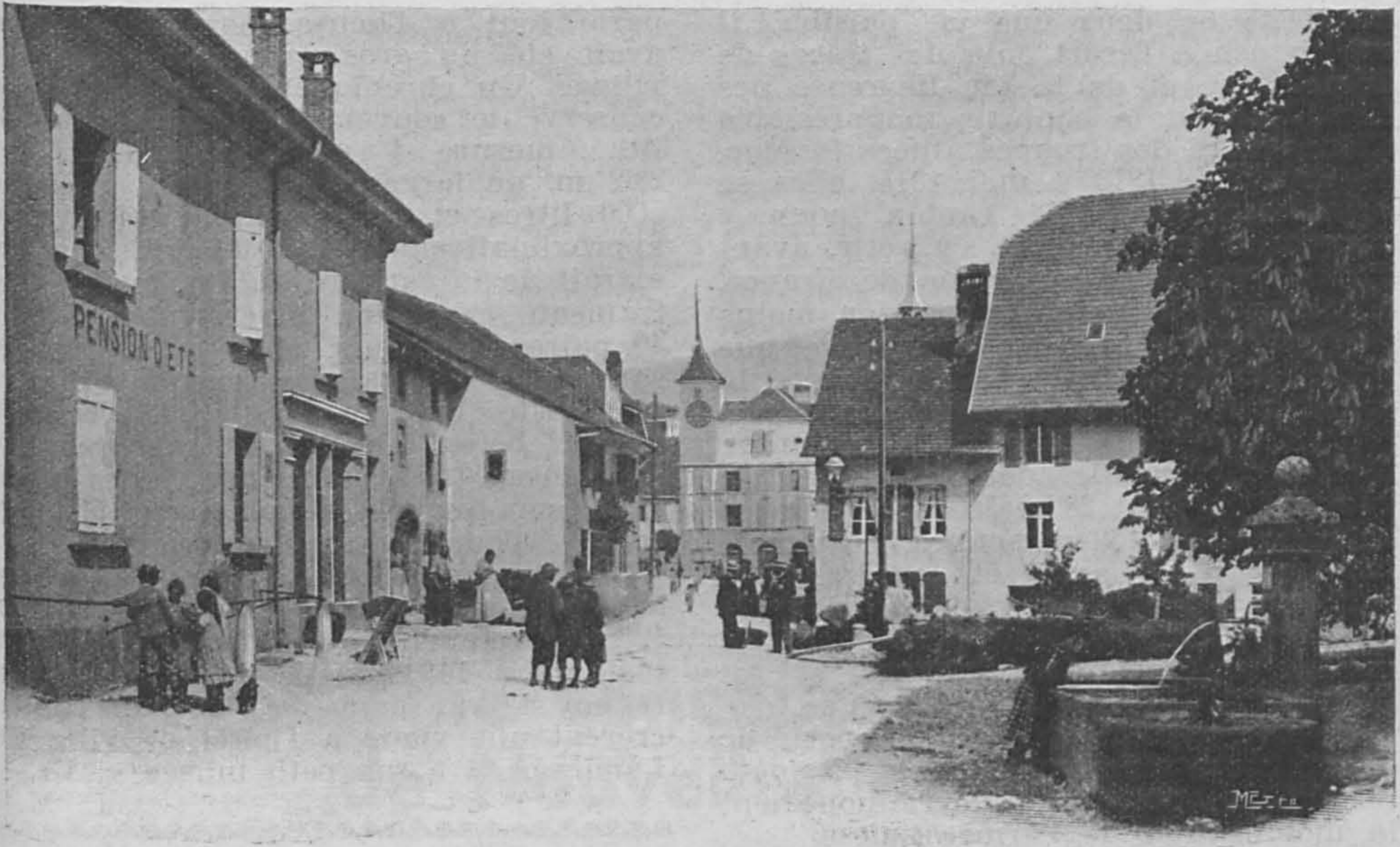
Lignières : l'hôtel de la Poste et la maison de commune.
