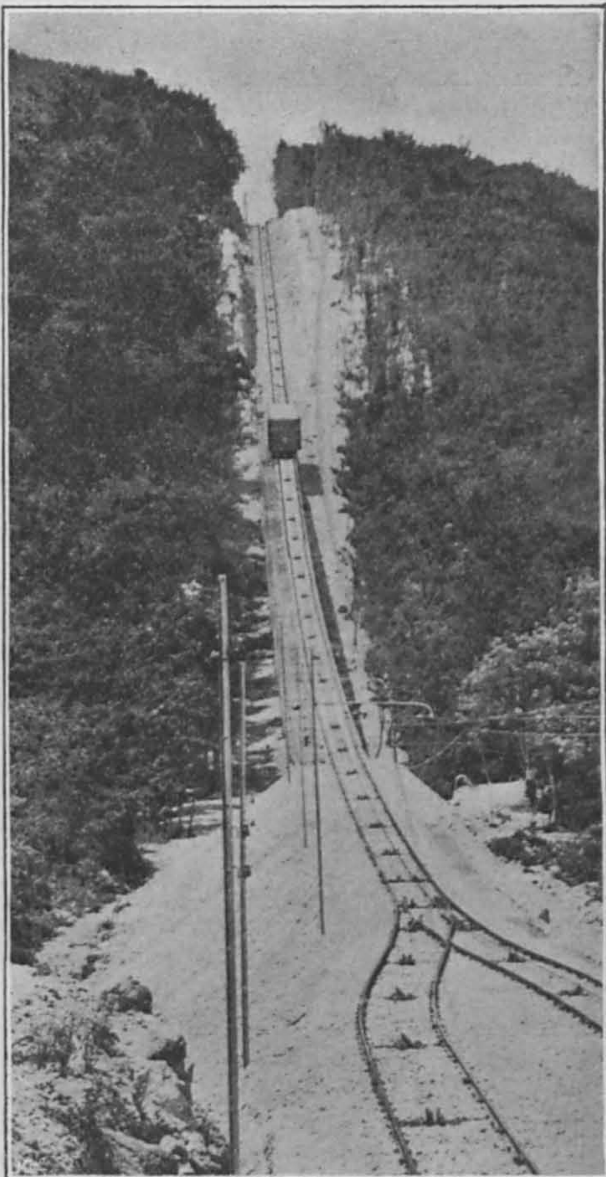
La grande rampe.
