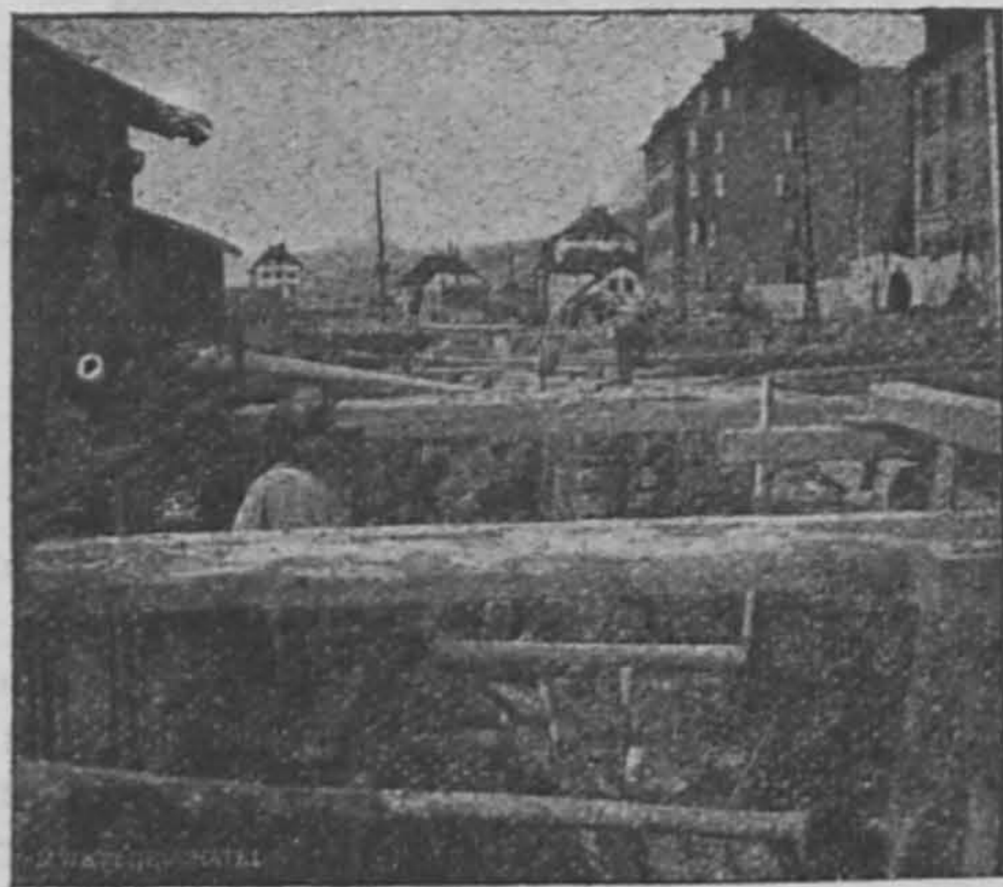
Travaux de canalisation à la sortie de ville.
