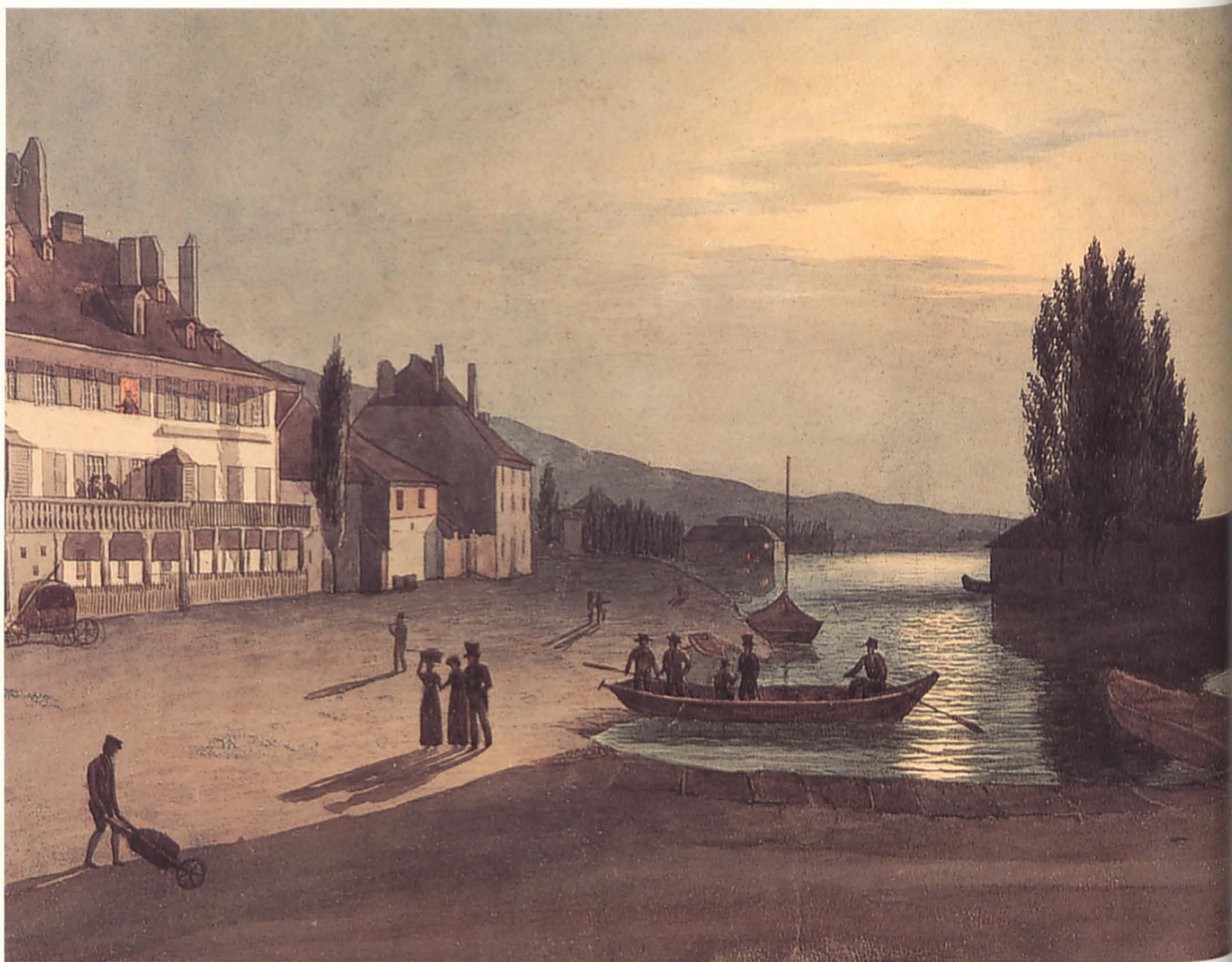
Face au lac, l'imprimerie de la Société typographique de Neuchâtel (immeuble à gauche au premier plan) occupe un emplacement idyllique.
