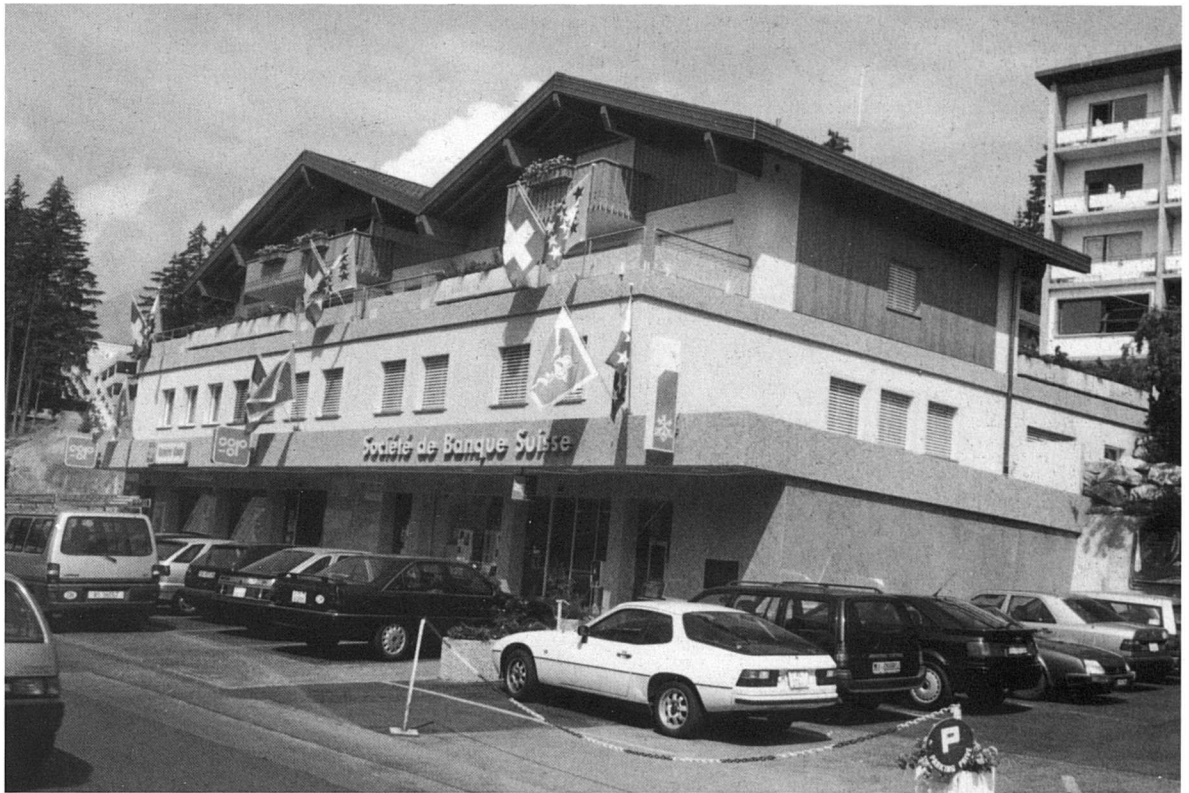
Neubau in Crans-Montana (Aufnahme 1992).
