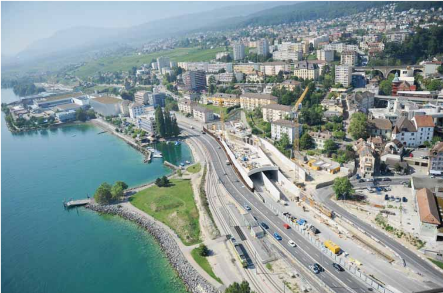
Le portail est du tunnel de Serrières où le bétonnage de la dalle de couverture de la future route cantonale 5 est en cours. ENNIO BETTINELLI
