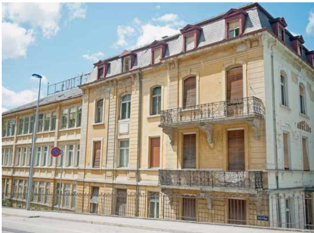
L'énorme Angelus, rue Alexis-Marie Piaget, commence à montrer des signes de dégradations. Qui souhaite acheter ce bâtiment (pour environ 2,5 millions) avant qu'il ne devienne une friche? DAVID MARCHON
