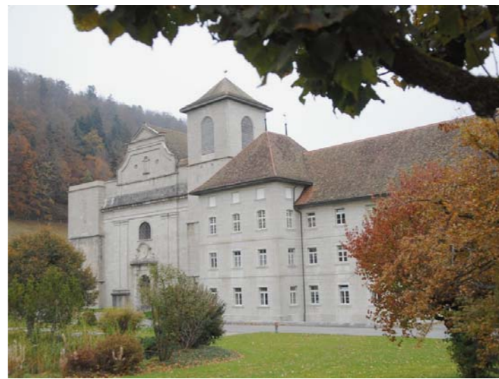
L'église actuelle, de style baroque, date du début du 18e siècle, mais la fondation de l'abbaye, elle, remonte au 12e siècle. BIST-STÉPHANE GERBER
