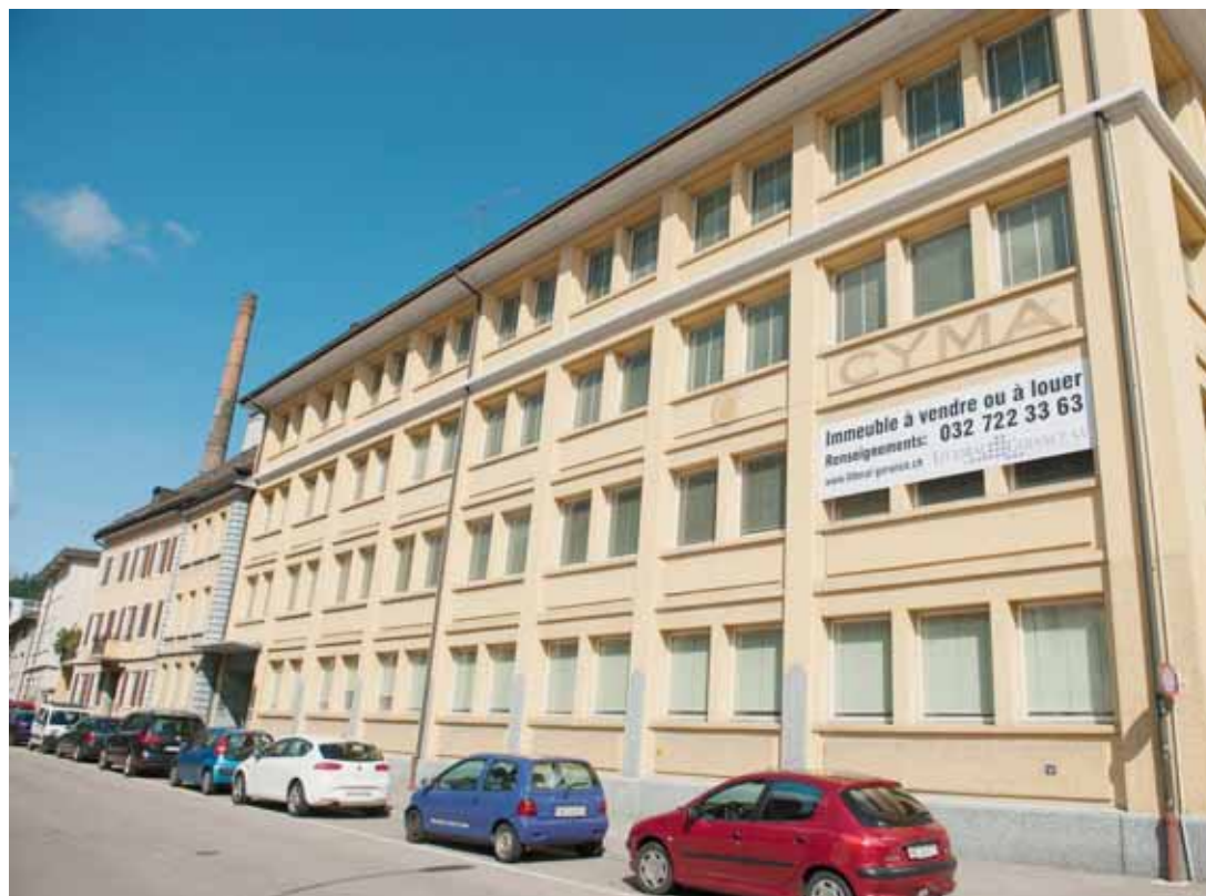
Stores baissés, le bâtiment qui abritait l'entreprise Cyma, rue des Billodes, est aujourd'hui désert. Pour 1,8 million, vous en devenez l'heureux propriétaire. DAVID MARCHON
