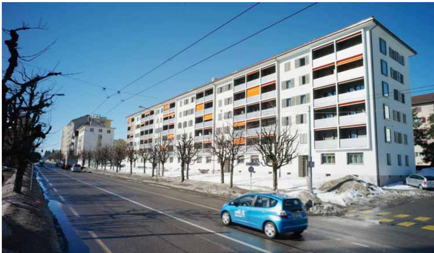
Qui sait que le propriétaire de cet immeuble des années 1950, de six étages, cinq entrées et 81 appartements n'est autre que le syndicat Unia? Il vient de rénover à fond son enveloppe pour 2,5 millions de francs. Avec à la clé une sacrée économie d'énergie à venir. CHRISTIAN GALLEY
