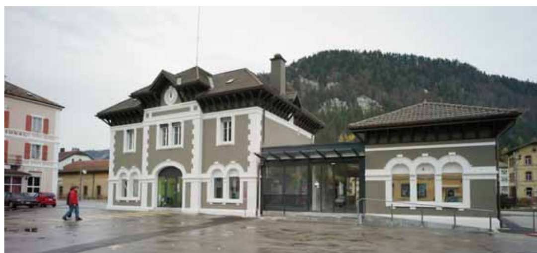
Le bâtiment a été entièrement rénové, des travaux devisés à 1,7 million de francs. CHRISTIAN GALLEY
