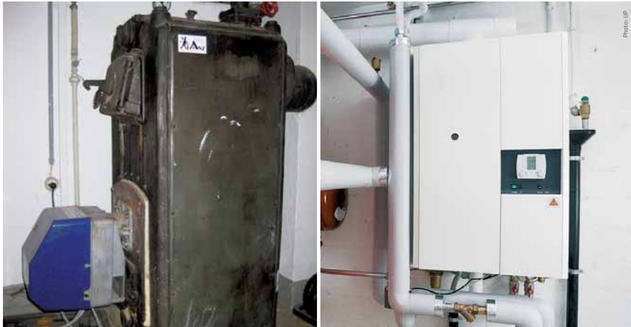
Les vieux chauffages à mazout occupent beaucoup d'espace et gaspillent de l'énergie. Les chaudières murales modernes prennent peu de place et libèrent ainsi un espace utile intéressant.
