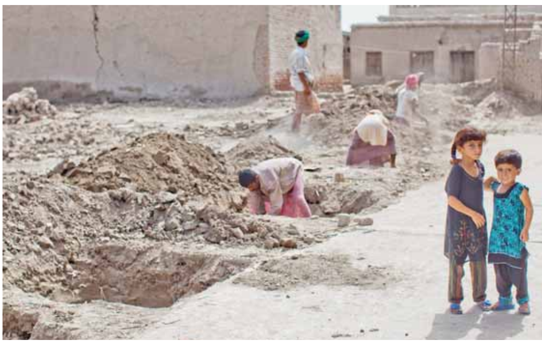
A Bhadarpur, les trous pour les fondations des maisons viennent d'être creusés. OLIVIER MATTHYS
