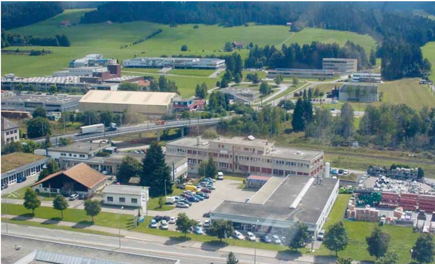
Le discours convenu sur La Chaux-de-Fonds, c'est de souligner la densité du bâti. La réalité, mise en valeur par les étudiants et visible sur cette image, c'est qu'il existe de grandes zones moins denses, où la mixité de l'habitat est absente. ARCHIVES RICHARD LEUENBERGER
