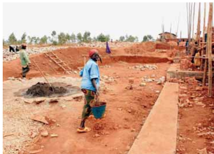
Début de la construction du centre de formation en hygiène et assainissement à Mugeru en 2008. SP
