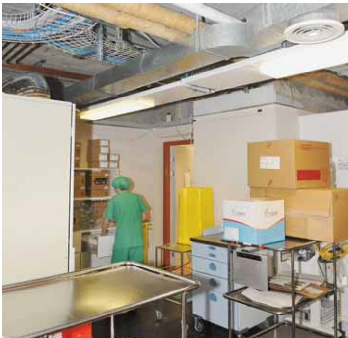
Le site de l'Hôpital neuchâtelois devrait être le théâtre de diverses rénovations ces prochains mois. (ARCHIVES RICHARD LEUENBERGER)
