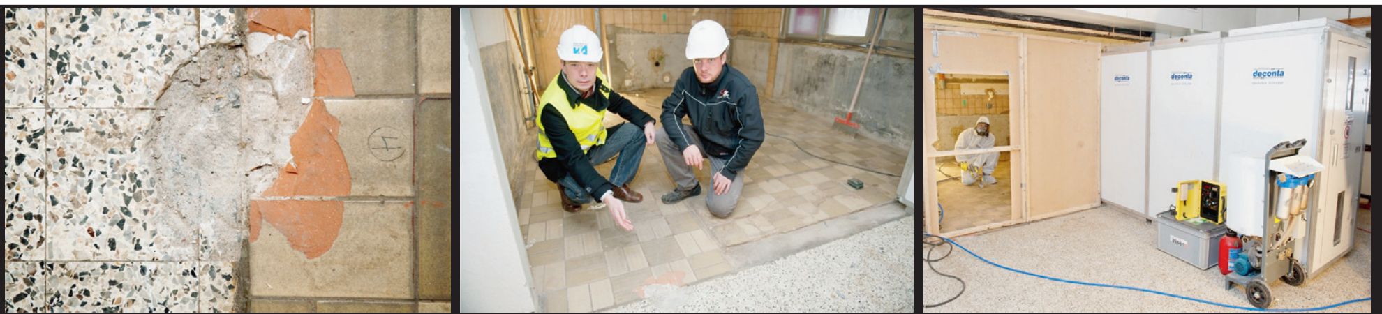
TRAVAUX A gauche, le carrelage dont la colle recèle de l'amiante. Au centre, les responsables du chantier Raoul Bovay et Jérôme Schoeni. A droite, le sas de décontamination.
