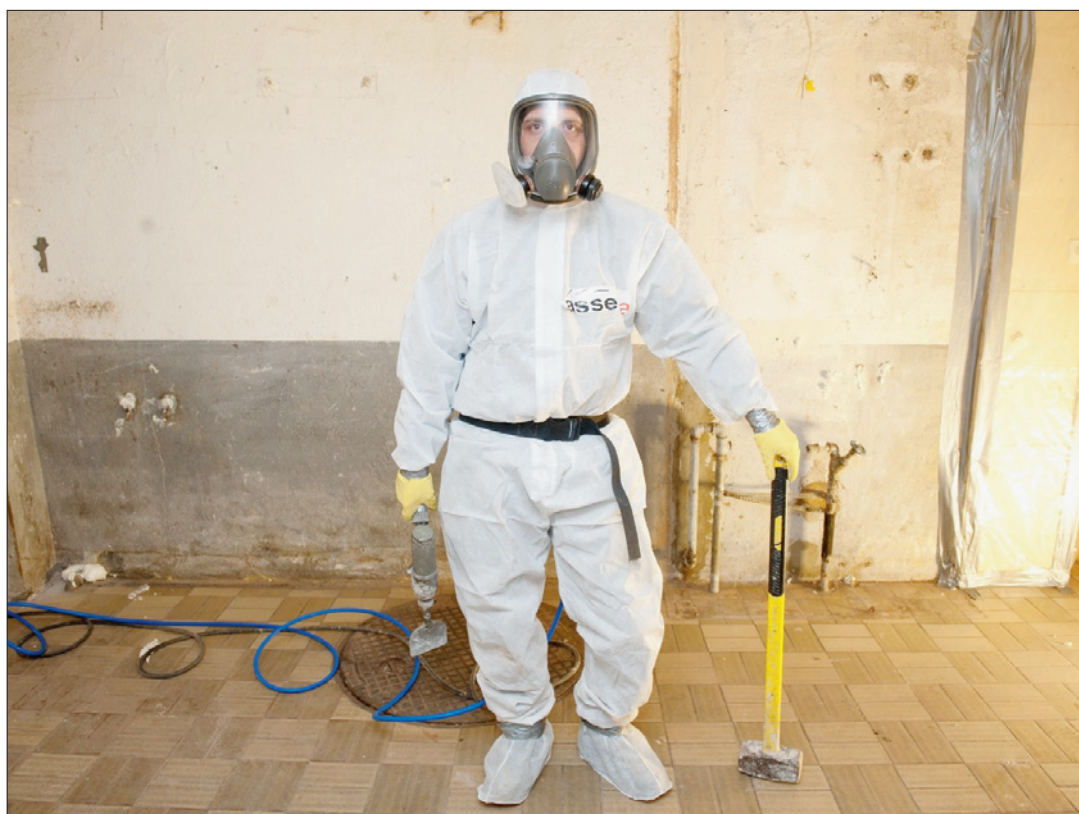
PARÉ Combinaison étanche et masque à oxygène sont de rigueur pour éliminer l'amiante.
