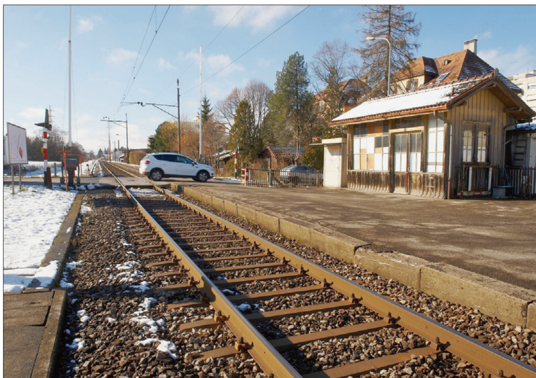
MORGARTEN Au premier plan, le futur emplacement de la gare de la Fiaz, avec un quai de 155 mètres, une marquise, un abri, des haut-parleurs et un automate à billets.
