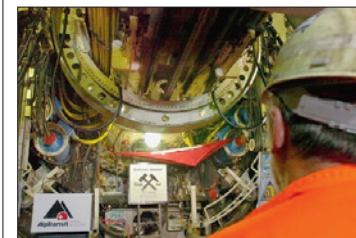
TUNNEL FERROVIAIRE L'ouvrage pourrait être exploité dès 2016. (KEYSTONE)
