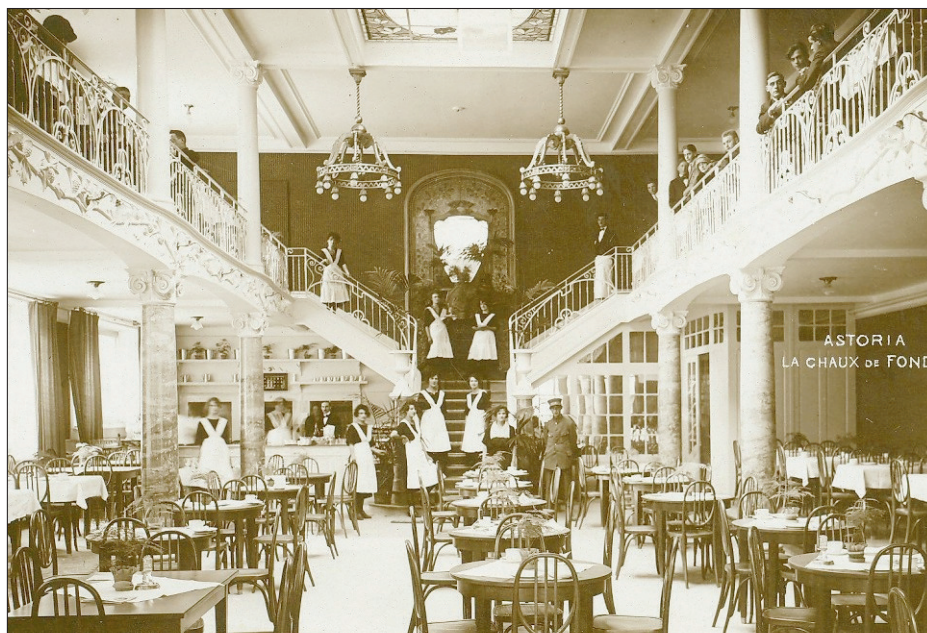
L'ASTORIA Si l'extérieur ne payait pas vraiment de mine, l'aménagement intérieur dans un style Art nouveau était somptueux,
