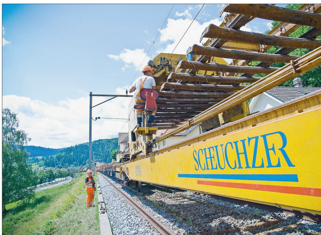
TRAVAUX Avec ces 62 tonnes et 30 mètres de long, la machine Puma a permis aux travailleurs du chantier de retirer les anciens rails de la voie entre Le Locle et Le Col-des-Roches. (GUILLAUME PERRET)
