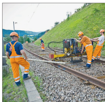
RAILS La poseuse à rails permet d'ajuster l'écartement. (GUILLAUME PERRET)
