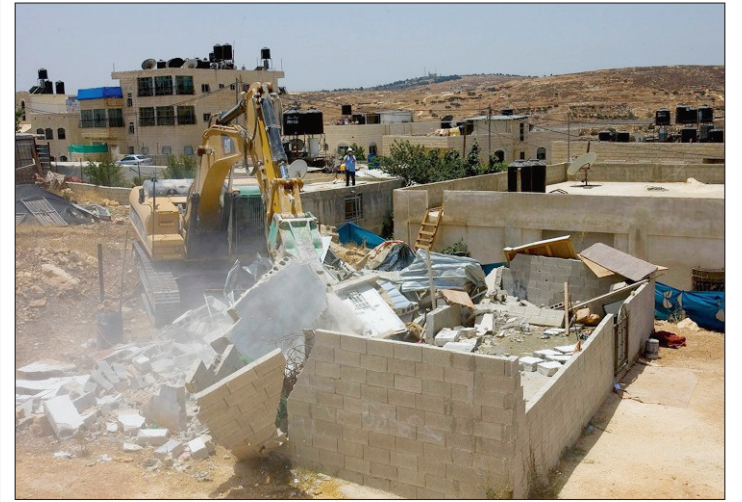
BULLDOZERS À L'ŒUVRE Les autorités israéliennes ont procédé à de nouvelles démolitions de maisons familiales palestiniennes dans le territoire occupé de Jérusalem-Est. (KEYSTONE)
